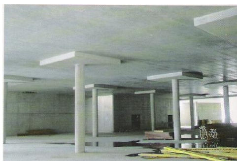
Fig. 3.4 – Esquema e exemplo de lajes fungiformes maciças com capitéis de espessura constante.
