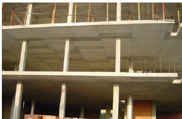
Fig. 3.2 – Esquema e exemplo de lajes fungiformes maciças com espessura constante.
