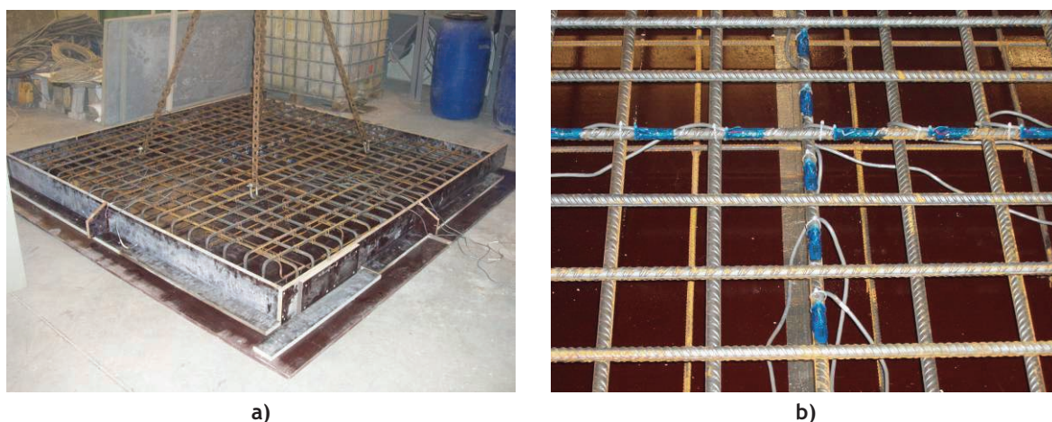
Figura V-21 - a) Vista geral das armaduras longitudinais da laje P; b) Pormenor da disposição dos extensómetros instalados nas armaduras longitudinais da laje P.
