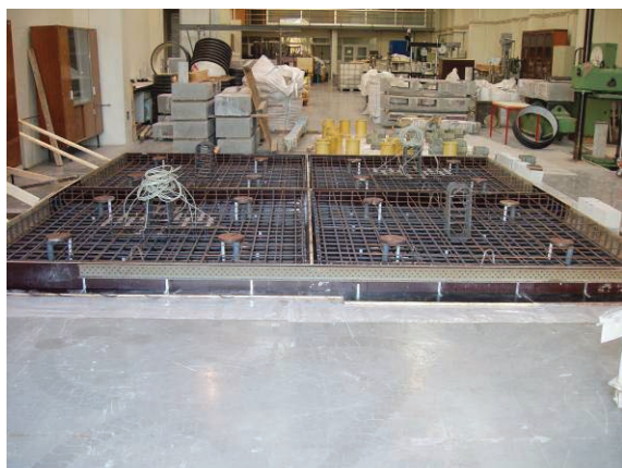
Figura V-8 - Vista geral da plataforma antes da betonagem da 1.ª série de lajes.
