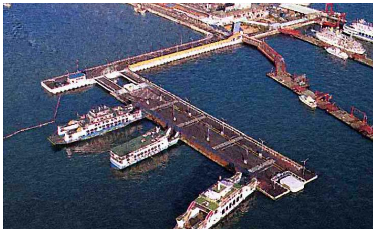
Fig. 3.47 – Cais flutuante no porto de Ujina (Watanabe et al. , 2004).
