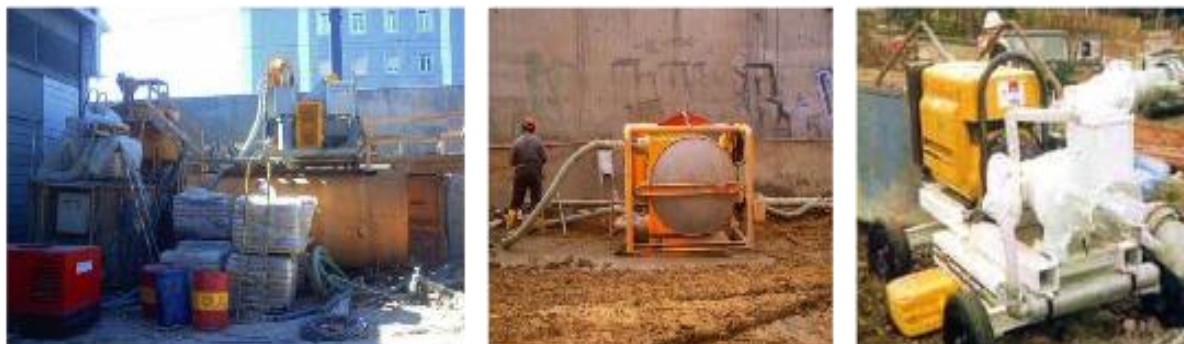
Fig. 3.37 – Equipamento de produção das lamas de sustentação (Sousa et al. , 2006).
