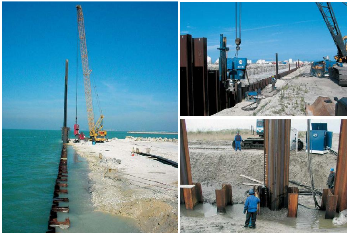
Fig. 3.18 – Esquerda: Colocação de estacas prancha no porto de Cadiz (Arcelor Mittal, 2005); Direita: Colocação de estacas prancha no porto de Aveiro (Arcelor Mittal, 2005).
