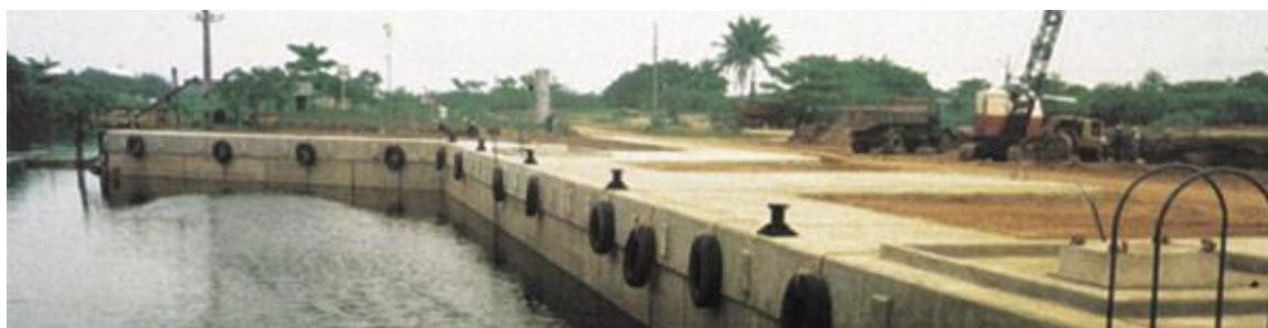
Fig. 3.42 – Vista final do cais de Barcaças de Petrobras ( http://www.fundesb.com.br/2009/obras.html ).
