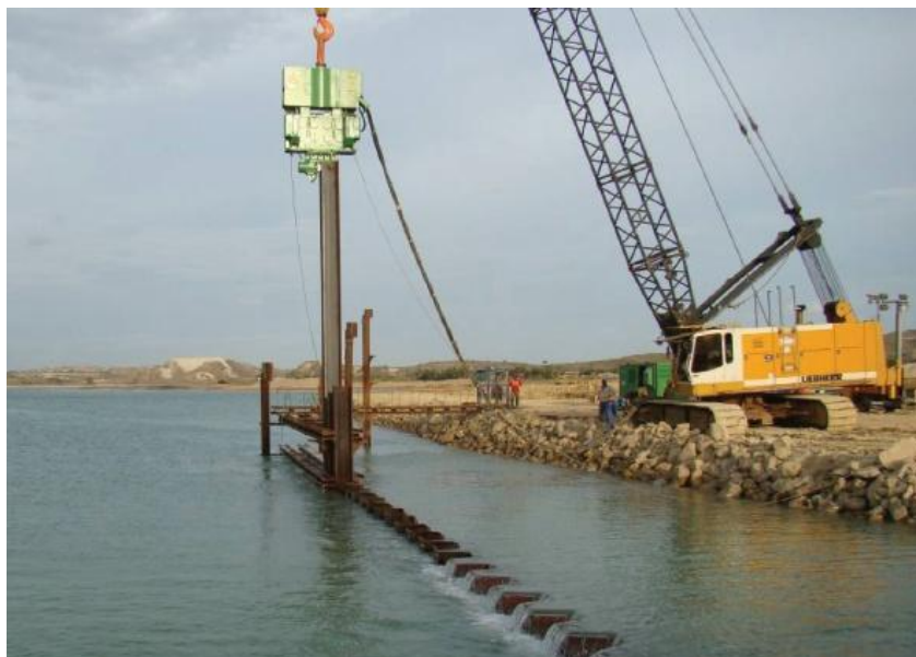
Fig. 3.16 – Utilização de um vibro-martelo hidráulico na colocação de estacas prancha (Arcelor Mittal, 2011).
