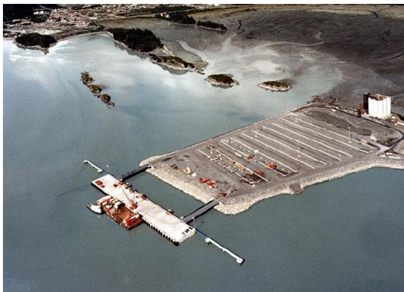
Fig. 3.48 – Cais flutuante com sistema de ancoragem “golfinho” ( http://www.abam.com/ ).
