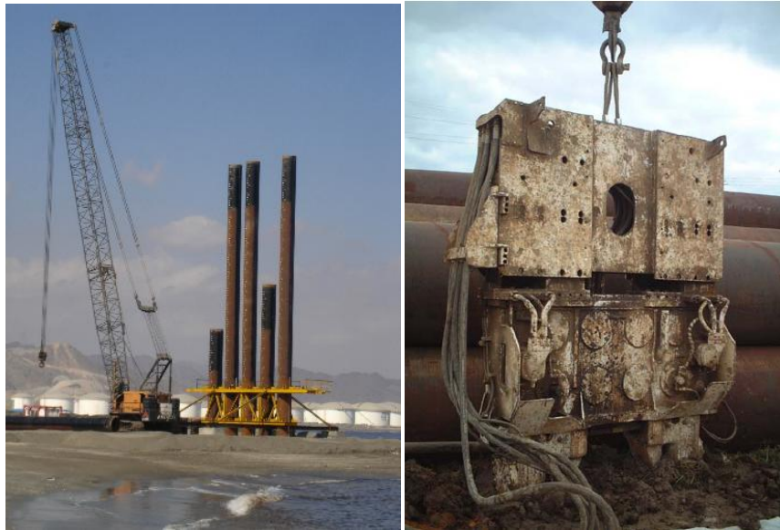
Fig. 3.31 – Esquerda: Colocação de estacas ( http://www.esccpile.com ); Direita: Exemplo de vibro-martelo utilizado na cravação de estacas (Costa Miranda, 2006).
