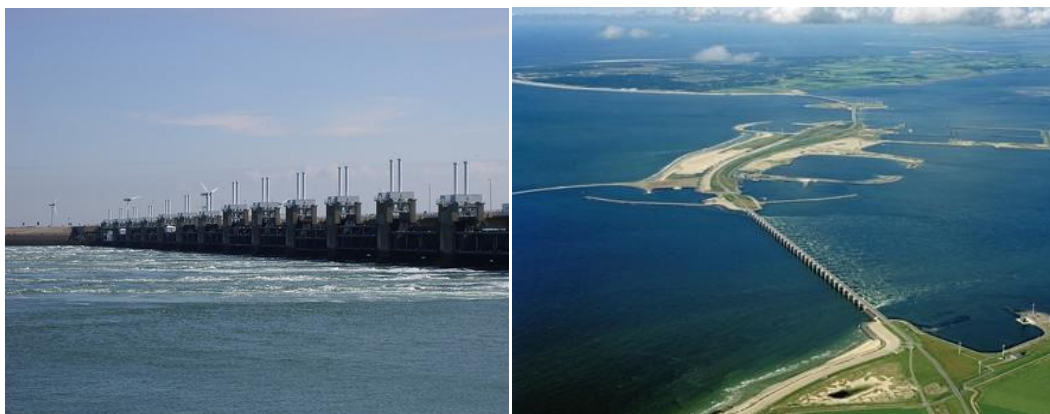
Figura 8: Um dique, uma estrutura hidráulica que protege o estuário do Scheldt da ondulação visto do oceano, à esquerda, e vista aérea, à direita (Deltawerken, 2011)
