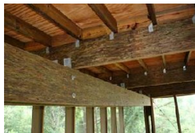
Figura 3.5. – Construção com PSL, [70].
