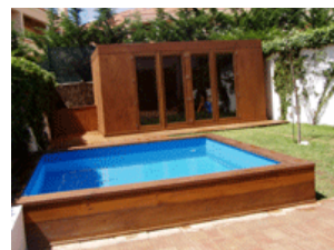
Figura 3.13. – Acabamento em contraplacado, [75].
