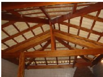
Figura 3.22. – Cobertura de madeira, [82].
