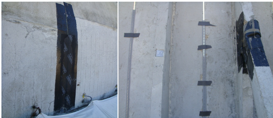
Fig.3.11 - Pormenor do tratamento das juntas do culvert na Auto-estrada do douro Litoral A41 (foto tirada durante a visita à obra, 2010)
