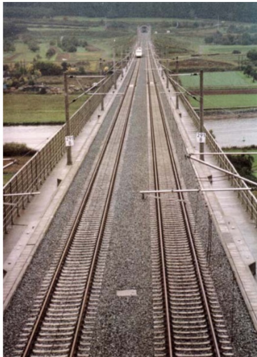
Fig.2.13 - Trecho de uma linha de alta velocidade Alemã (Riessberger, 2006)
