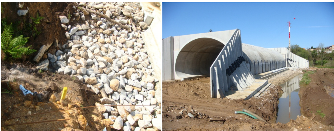
Fig.3. 9 - Condições da fundação e respectivo tratamento do solo de fundação (foto tirada durante a visita à obra, 2010)
