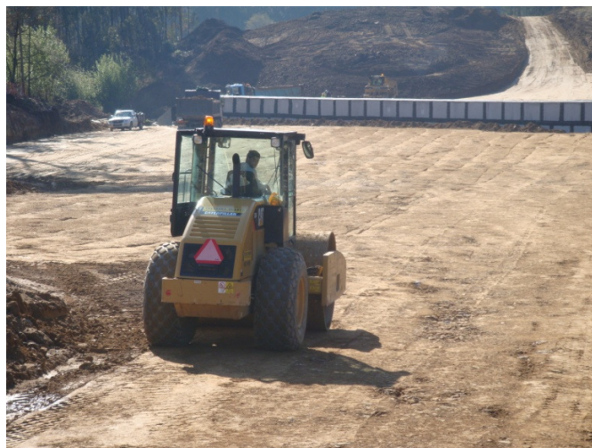
Fig.3. 14 - Trabalhos de Terraplanagem (na Auto-estrada do douro Litoral A41, foto tirada durante a visita à obra, 2010)
