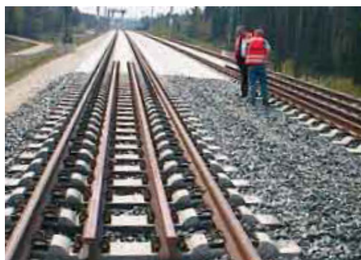
Fig.4. 19 – Introdução de carris extra ao longo da zona de uma zona de transição, (Railone, 2010)
