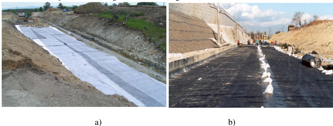
Fig.4. 20 - a) Reforço do solo de fundação com recurso a uma combinação de geotêxteis para aumentar a capacidade de carga de uma fundação de uma via férrea constituída por solos argilosos, num troço de uma via férrea entre Rudoltice e Cechach b) Aplicação da geomembrana para protecção do solo de fundação contra a presença de água (INNOTRACK, 2008)
