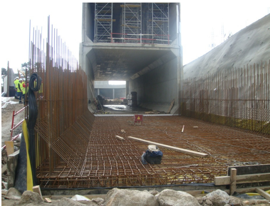
Fig.3. 2 - Box-culvert betonado “in situ” (foto tirada durante a visita a uma obra pelos alunos de geotecnia, 2010)
