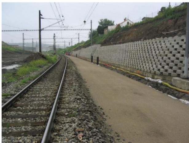
Fig.4. 21 - Estabilização do solo com cimento próxima da estação ferroviária de Praha-Liben (INNOTRACK, 2008)
