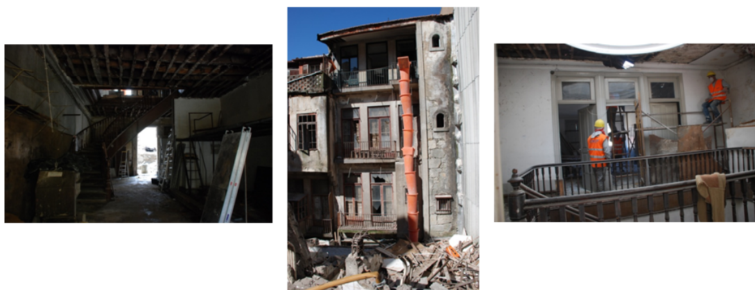
Fig. 23 Durante as obras
