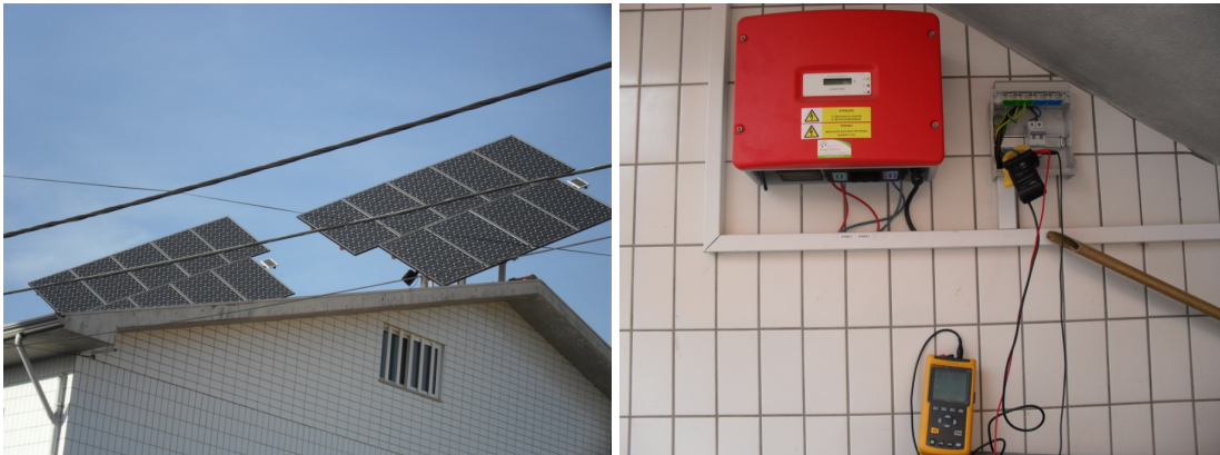
Figura 5.13. Montagem dos painéis fotovoltaicos e instalação do sistema Sunny Boy 3800/V.
