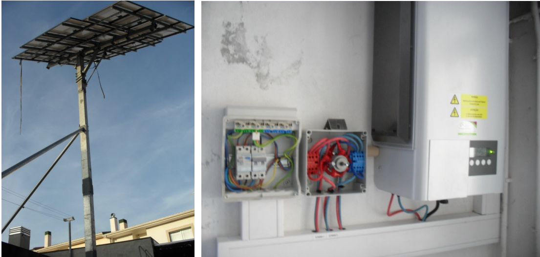
Figura 5.4. Montagem dos painéis fotovoltaicos e instalação do sistema Fronius IG 40.
