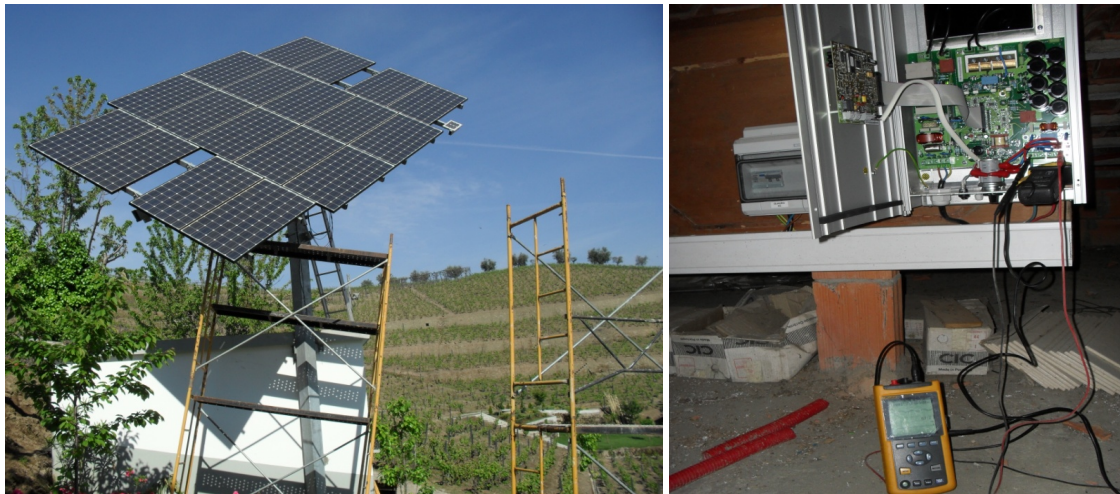
Figura 5.22. Instalação dos painéis fotovoltaicos e do inversor Kaco Powador 3600xi.
