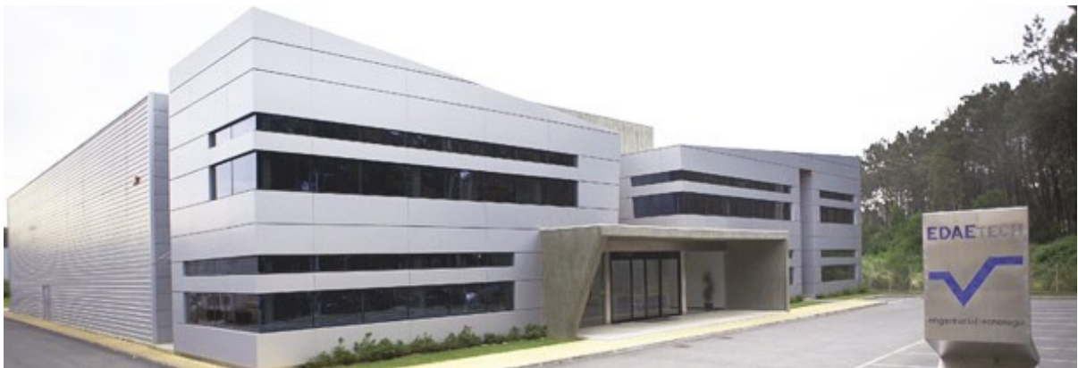
Figura 1 – Instalações da Edaetech
