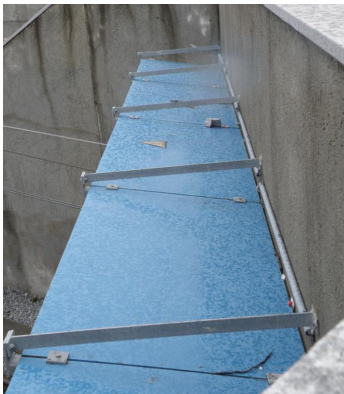
Fig. 24 – Protecções horizontais contra a queda de objectos
