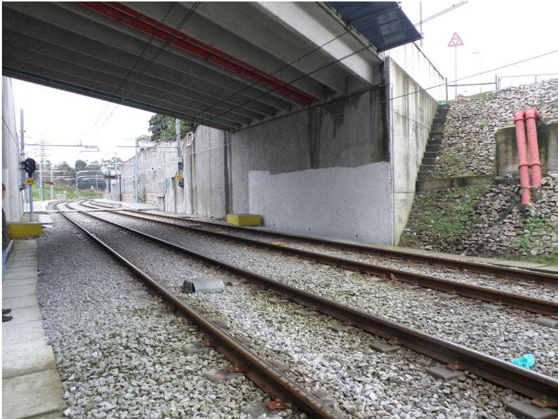
Fig. 23 – Passagem Superior, Estação Cândido dos Reis
