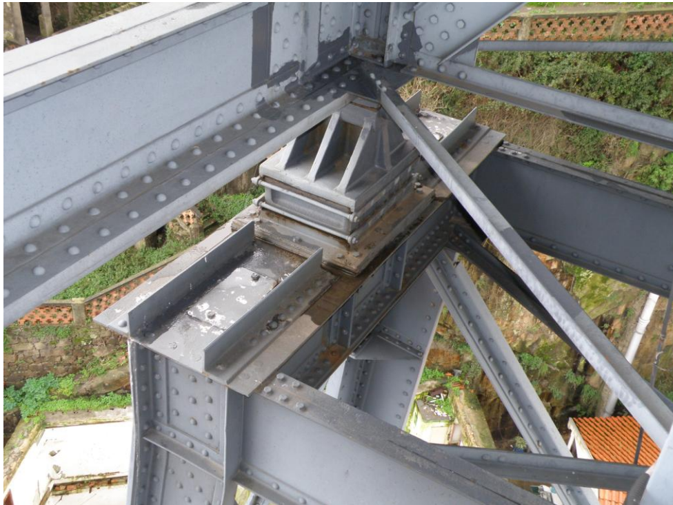
Fig. 28 – Ligação entre elementos e o apoio
