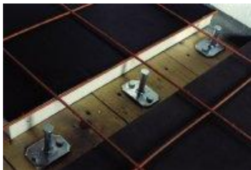
Fig. A.28 - Isolamento em pavimentos com ligadores Tecnaria
