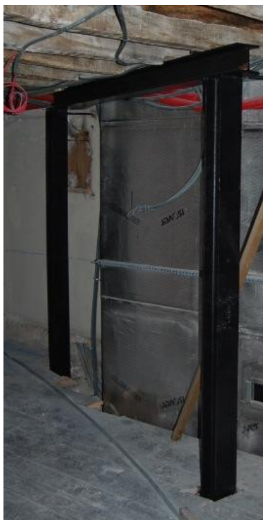
Fig. 2.25 - Escoramento do pavimento [19]
