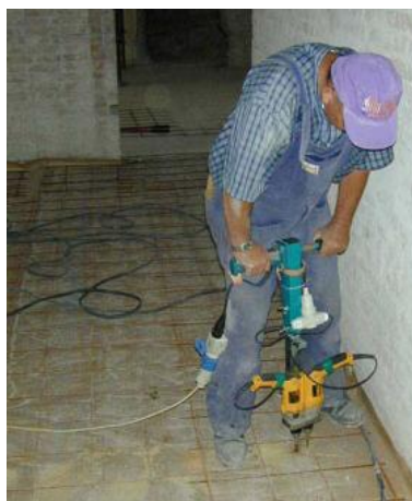
Fig. 2.29 - Furação para posterior colocação dos ligadores [77]
