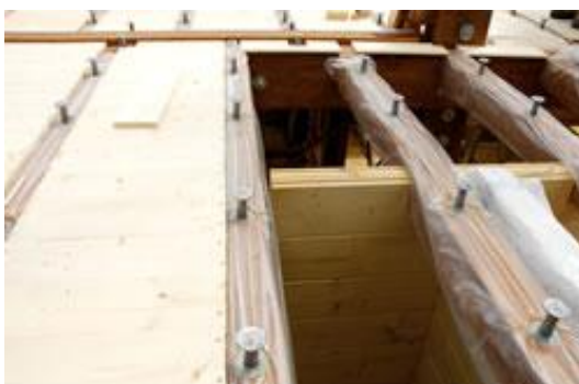
Fig. A.30 - Posicionamento de vigas e montagem de ligadores
