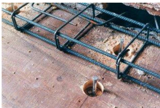
Fig. A.26 - Fixação dos ligadores
