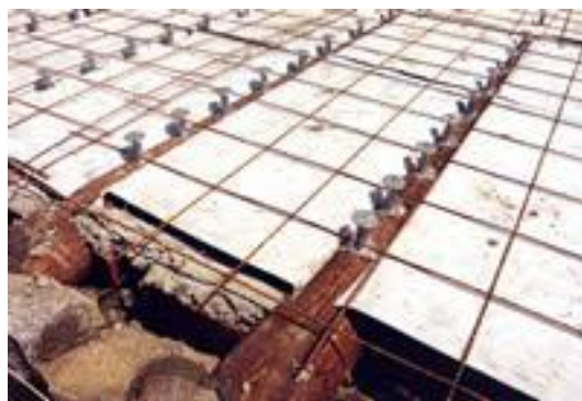
Fig. A.31 - Preparação da betonagem
