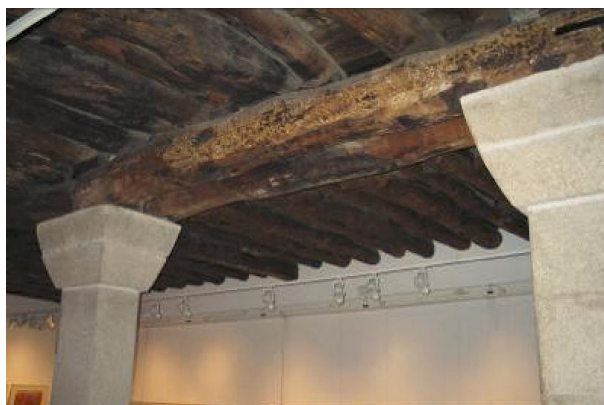
Fig. 2.6 - Colocação de vigas transversais para diminuição de vão, Casa do Infante, Porto [3]
