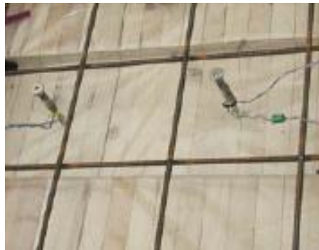
Fig. 3.37 - Cavidades e parafusos antes da colocação do betão [36]
