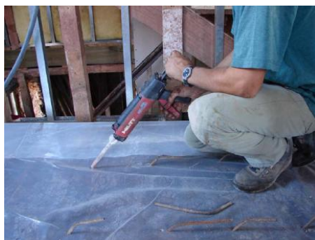
Fig. 2.28 - Colocação da tela impermeabilizante [6]
