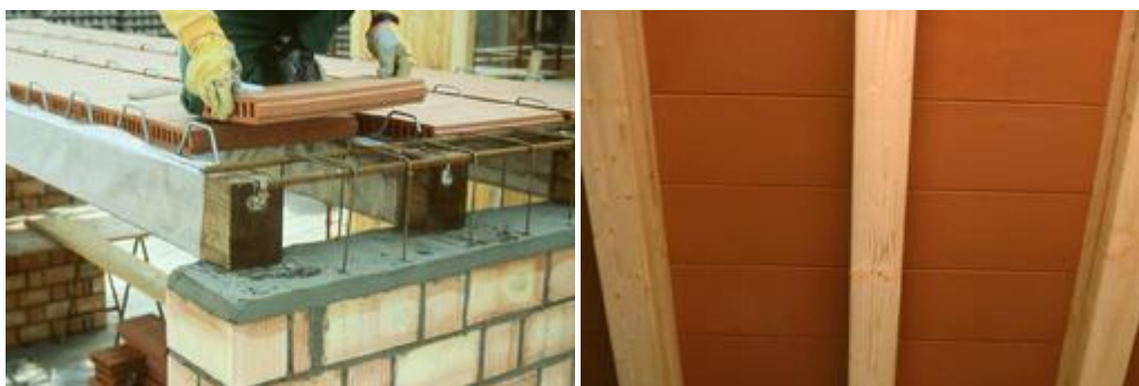
Fig. A.7 - Aplicação dos blocos cerâmicos e aspecto final do pavimento
