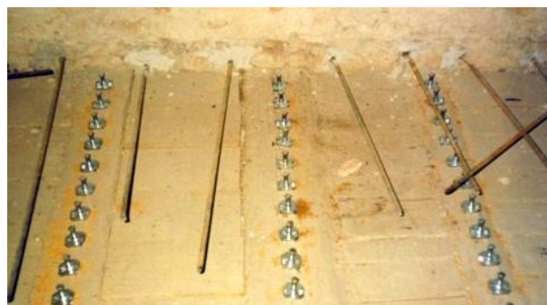
Fig. 2.24 - Transmissão de esforços para a parede estrutural [77]
