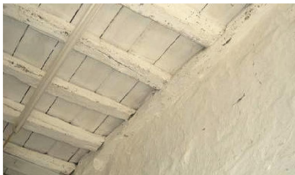
Fig. 2.5 - Vigas apoiadas em frechal. Palácio de Belomonte, Porto [3]
