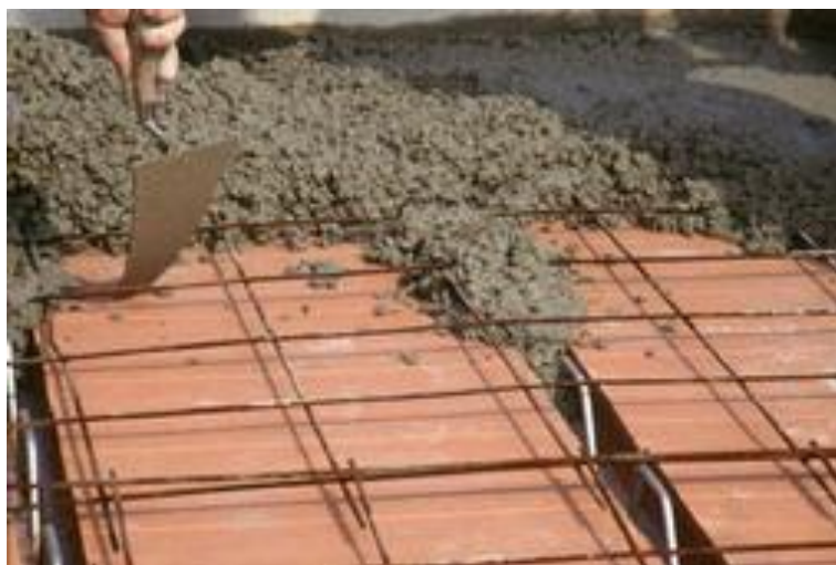
Fig. A.8 - Betonagem do pavimento
