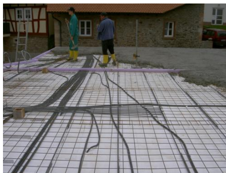
Fig. 2.32 -Betonagem da lâmina de betão
