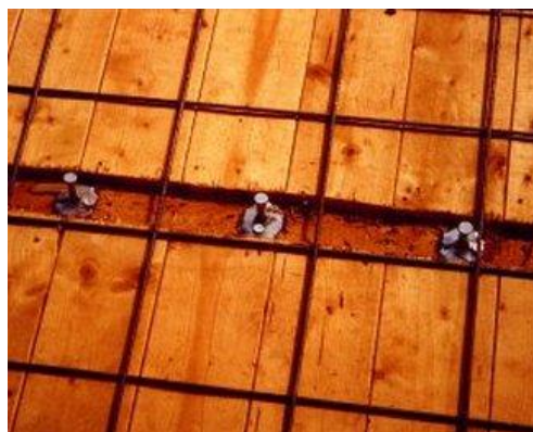
Fig. A.27 - Corredor contínuo com ligadores Tecnaria
