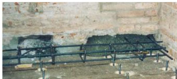
Fig. 2.23 - Reforço no perímetro da laje mista [77]
