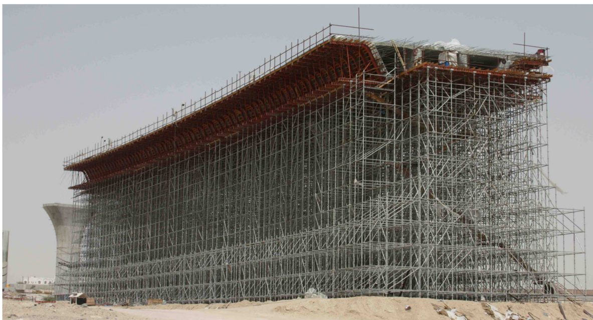
Figura 1 - Cibre ao Solo Contínuo [5]
