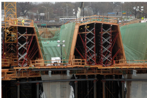
Figura 3 – Cofragem de Um Tabuleiro [7]
