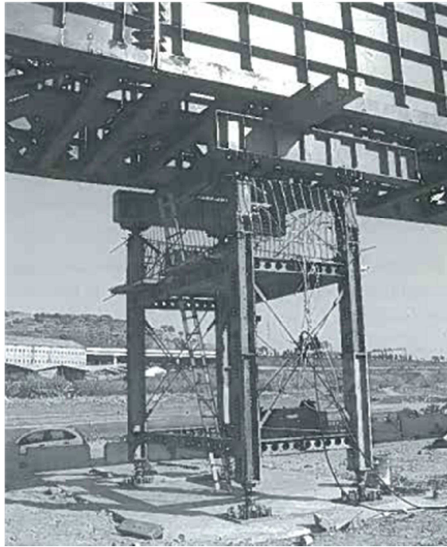
Figura 27 - Vigas Cruzadas Utilizadas Para Centrar e Distribuir Correctamente as Cargas [3]
