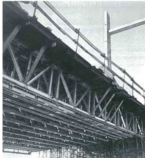
Figura 20 - Viga de Vão Metálica Construída em Treliça [3]
