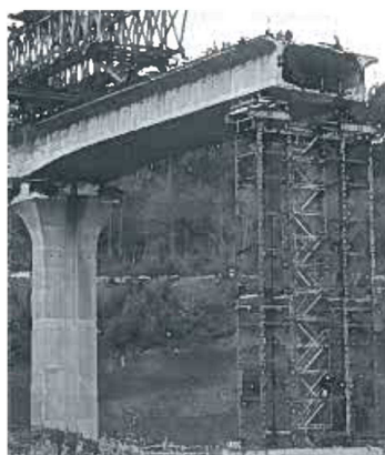
Figura 23 - Recurso a Uma Torre Para Auxiliar a Construção de Um Cimbra Auto-Lançável [3]
