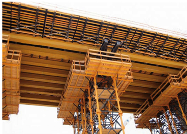
Figura 21 - Viga de Vão de Alma Cheia [14]
