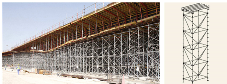
Figura 7 - Sistema de Cimbra ao Solo Contínuo Constituído por Torres em Tubo de Andaime [11] [12]
