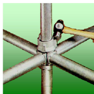
3 – Fixe o copo móvel com a ajuda de um martelo.
