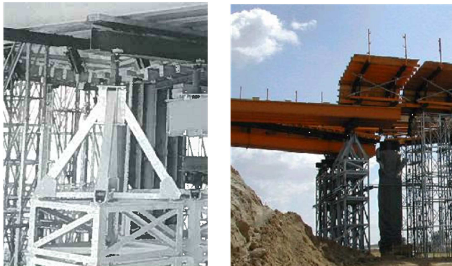
Figura 24 - Pirâmide Metálica Que Permite a Introdução da Carga Numa Torre de Forma Centrada [3] [16]
