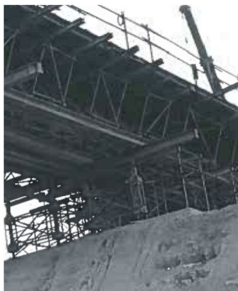
Figura 10 - Cimbra Instalado Sobre Uma Fundação [3]
