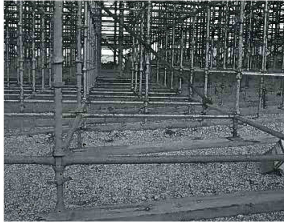
Figura 18 - Sistema de Cimbra Com Nós Semi-Rígidos [3]
