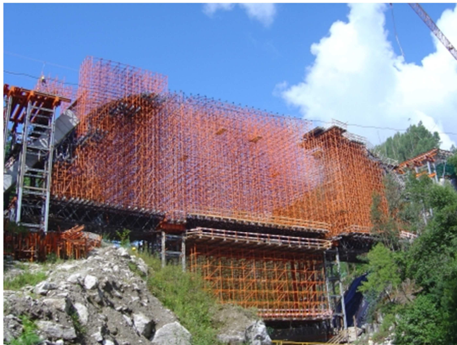
Figura 6 - Sistema de Cimbra Constituído Por Tubos de Andaime Ligados Entre Si de Forma Contínua [10]
