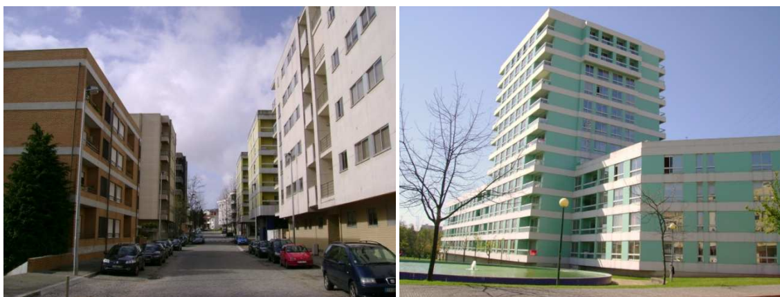
Fig. 19 – Exemplos de habitações multifamiliares. À esquerda habitações de 4 e 5 pisos na Rua Fernando Pessoa e à direita Torre do Lago (vista da Rua Manuel Gonçalves Ramos) com um máximo de 11 pisos.
