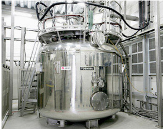
Figura 2.8 - O maior sistema de armazenamento magnético através de supercondutores
