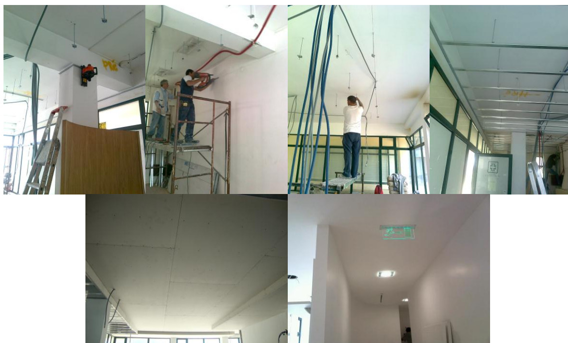
Fig. 6.7 – Diversas fotografias da execução da obra
