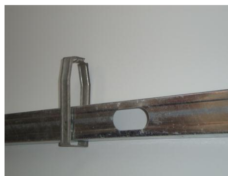
Fig. 3.5 - Tectos suspensos simples com montantes
