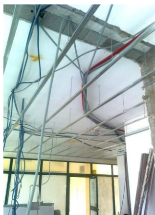
Fig. 5.8 – Cablagem apoiada directamente nas placas de gesso cartonado (sem esteira)
