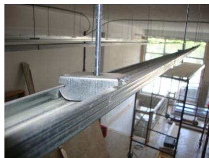
Fig. 3.3 Tectos suspensos simples – Suspensão com varão
