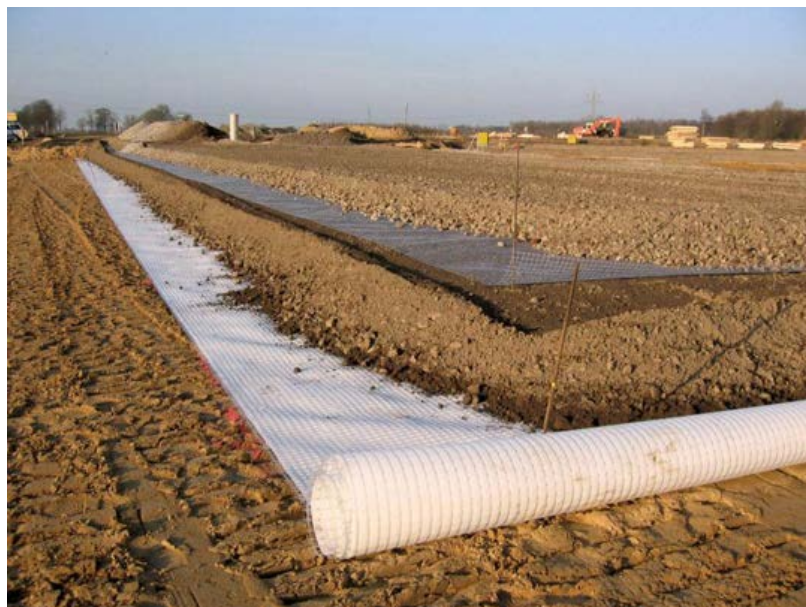
Fig. 4.6 - Geocompósito (Pereira, 2003)
