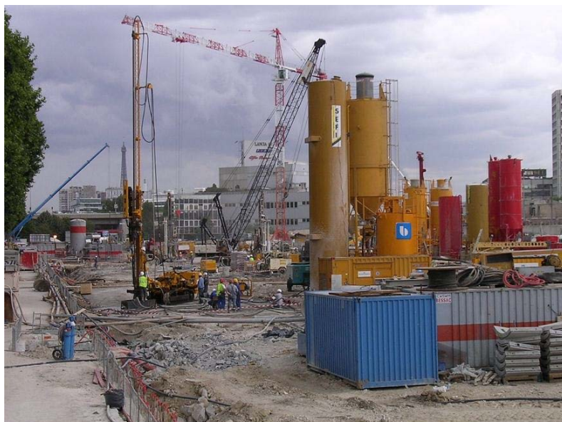
Fig. 3.3 - Estaleiro da técnica jet grouting [2]
