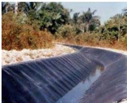
Fig. 4.12 - Geomembrana (Sieira, 2003)
