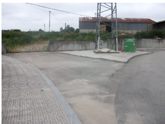
Figura 63 – Entrada da Zona 5
