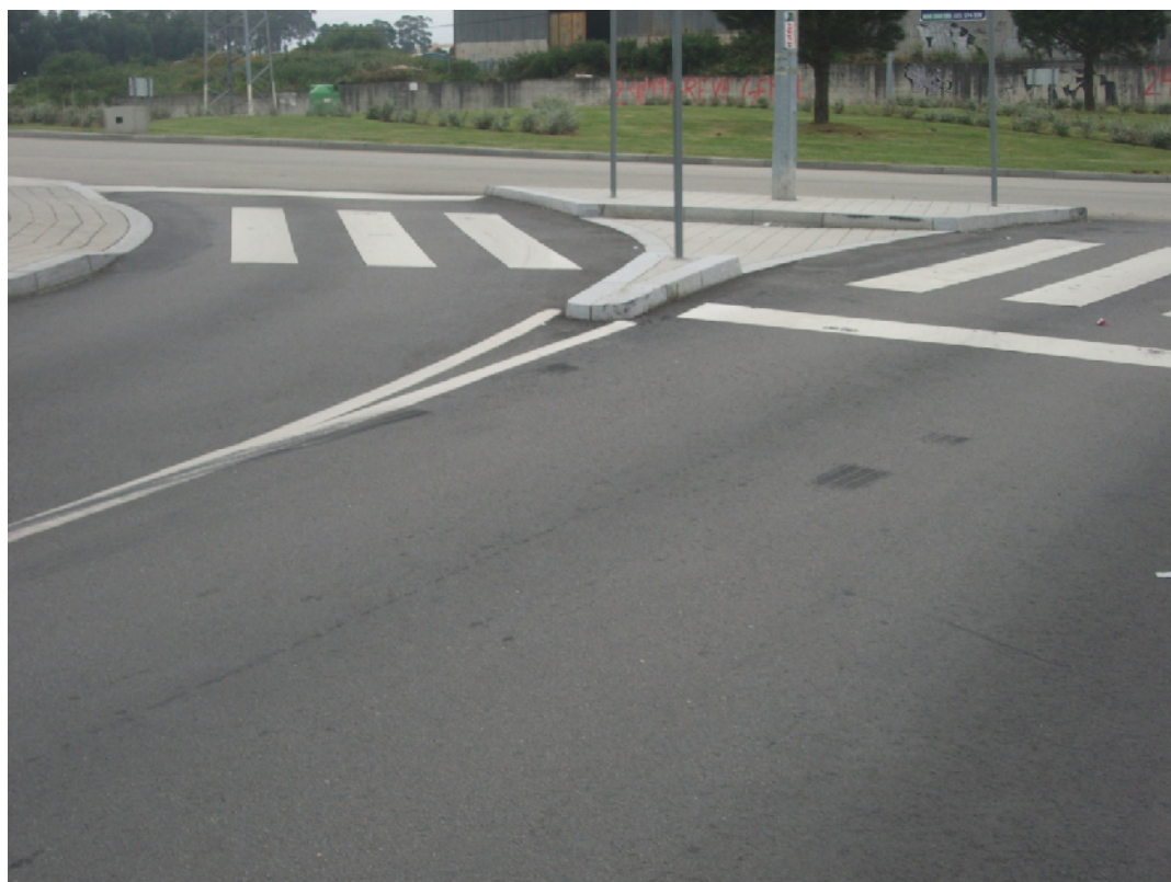
Figura 42 – Entrada da Zona 3
