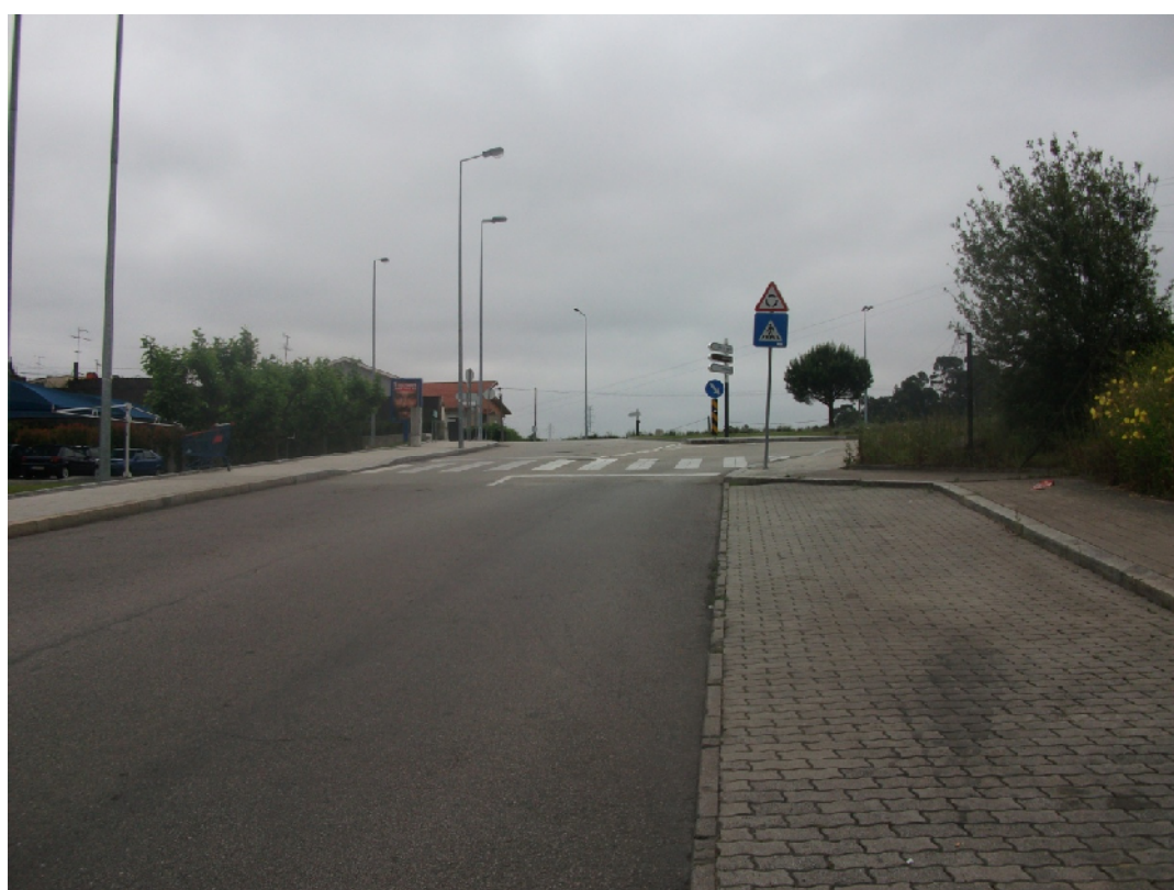
Figura 32 – Entrada da Zona 2
