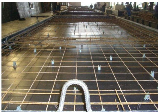
Fig. 6.19 - Aspecto da mesa preparada para receber o BAC, para elemento parede
