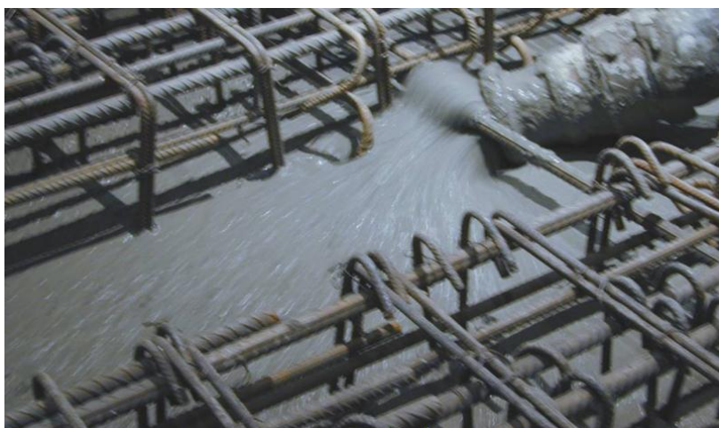
Fig. 6.25 - Betonagem de laje maciça
