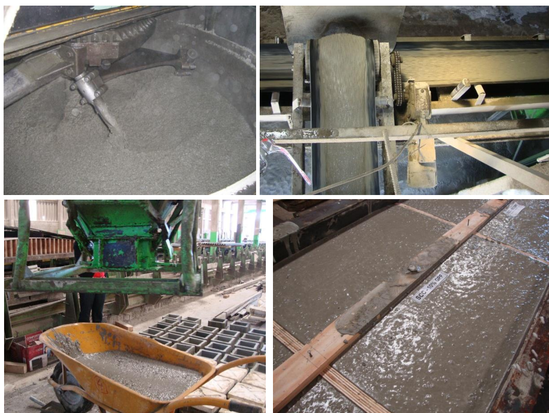
Fig. 6.5 - Produção, transporte e colocação do BAC nos moldes
