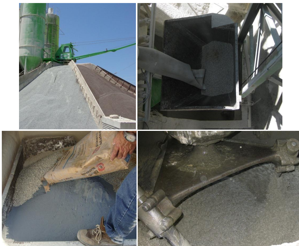
Fig. 6.4 - Central de betão
