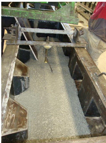
Fig. 6.7 - Betonagem do molde para peça Lego
