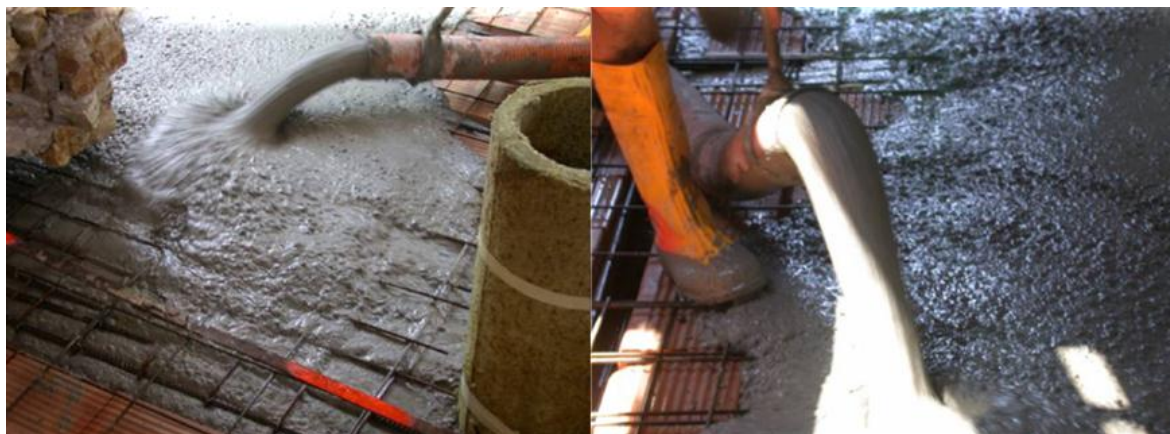
Fig. 6.26 - Betonagem de laje aligeirada
