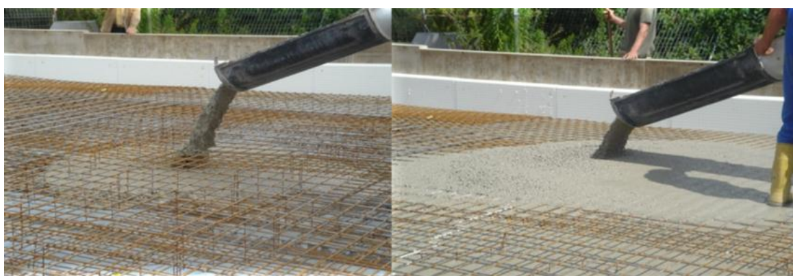
Fig. 6.27 - Betonagem de laje maciça por descarga directa da autobetoneira (EUROMODAL)
