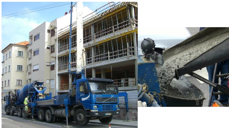
Fig. 6.24 - Bombagem do BAC-MV 20%GPF
