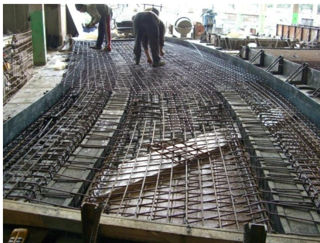
Fig. 6.21 - Aspecto do molde e armadura, para a produção do carril
