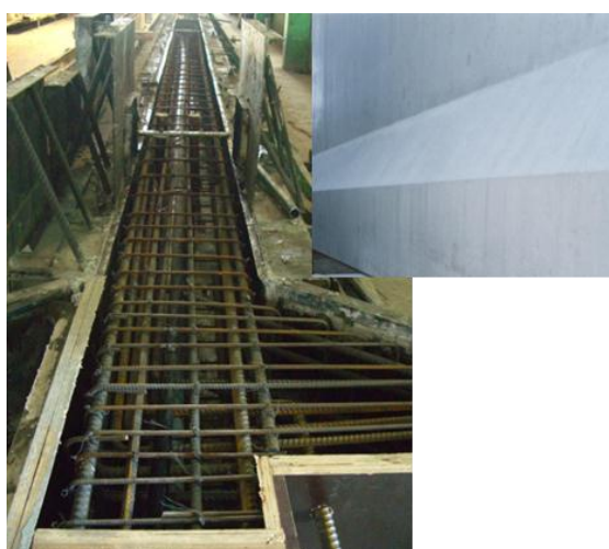
Fig. 6.20 - Aspecto da viga/pilar antes e após betonagem
