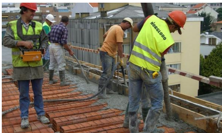
Fig. 2.1 - Trabalho de vibração em betonagem de laje
