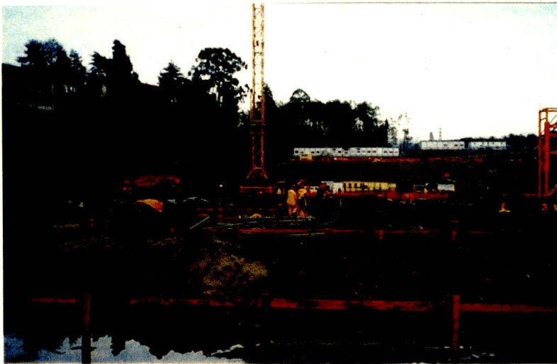
Figura 47: Início da construção
