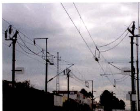
Figura 17 - Zona Neutra com Isoladores de Secção.
