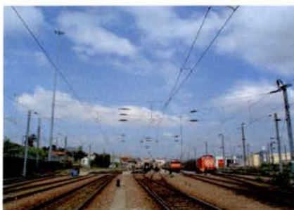
Figura 4 - Linha de contacto simples
