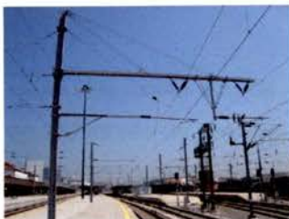
Figura 12 -Consola para plataformas altas e consola dupla
