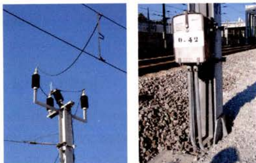
Figura 26 - Seccionador telecomandado
