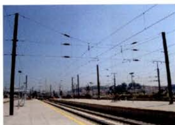
Figura 11 - Apoios em estações - Pórtico flexível
