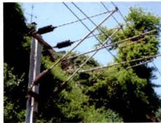
Figura 12 -Consola para plataformas altas e consola dupla
