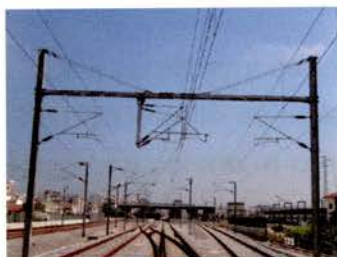
Figura 10 - Apoios em estações - Pórtico rígido
