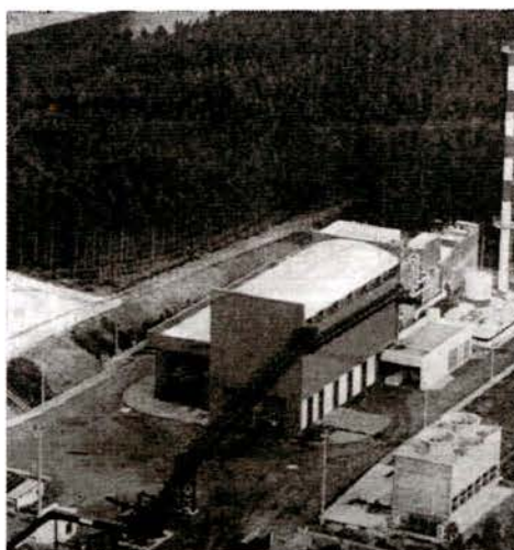
Figura 0.2: Central Termoelétrica de Mortágua
