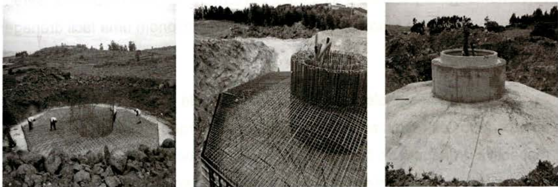
Figura 2 – construção das fundações: início da montagem do ferro, ferro montado e fundação concluída, respectivamente
