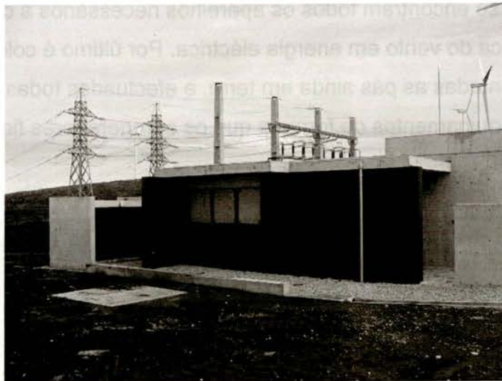
Figura 4 – Exemplo da Subestação e Edifício de Comando
