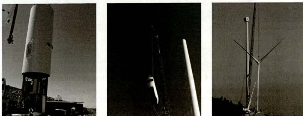
Figura 5 – Montagem da Torre, da Nacelle e do Rotor
