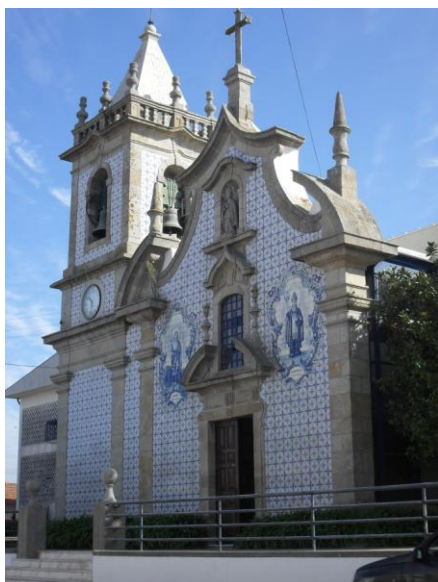
Figura 24 – Fachada principal da Igreja Paroquial de Anta
