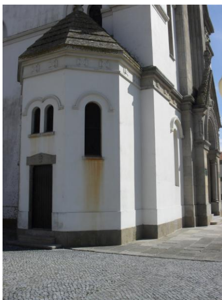
Figura 5 – Pormenor do volume externo do baptistério da Igreja Matriz de Espinho
