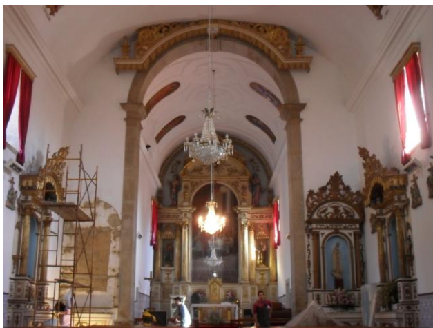
Figura 52 – Interior da Igreja Paroquial de Paramos
