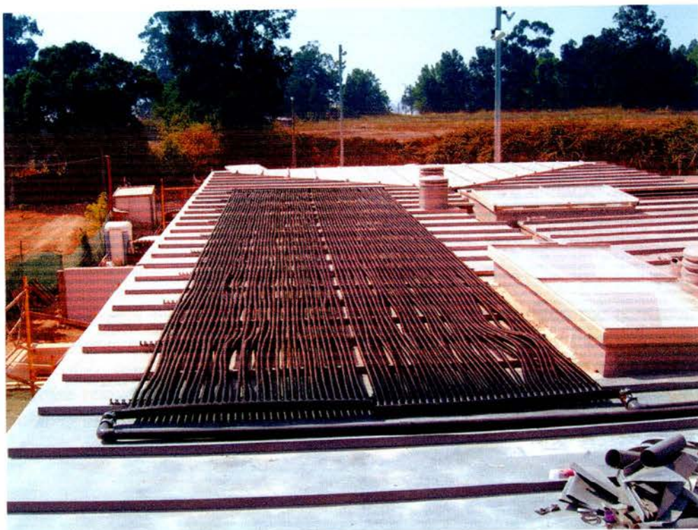
Fig. 4. – Sistema em tubos de polipropileno de Aldoar
