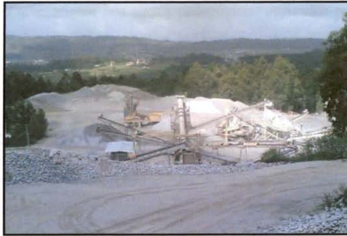
Figura 3.2: Vista geral dos silos
