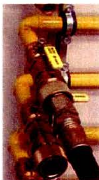
Figura 3-13 – sistema de aperto fácil do circuito de gás
