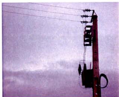
Figura 7. Apoio fim de linha
