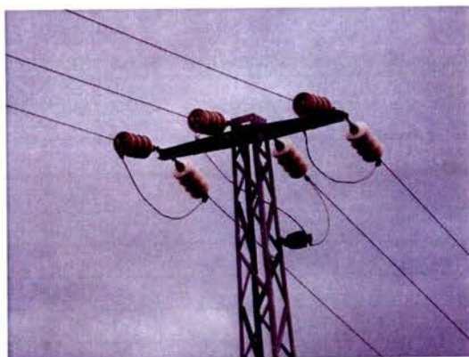
Figura 6. Disposição em esteira horizontal
