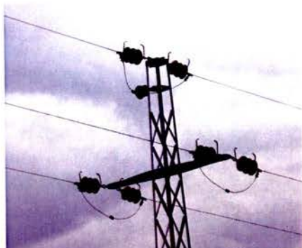
Figura 4. Disposição em triângulo
