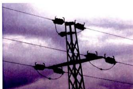
Figura 9. Apoio de alinhamento
