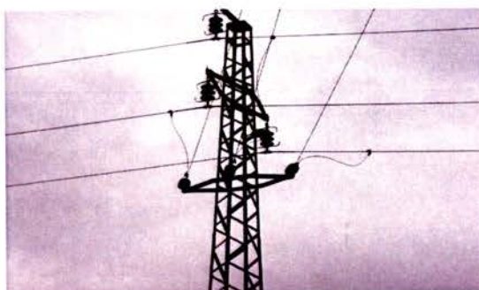
Figura 8. Apoio de derivação
