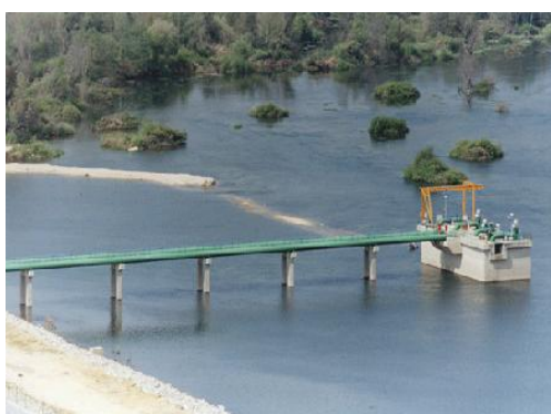
Figura 8. Captação (Águas do Cávado, S.A., 2009).
