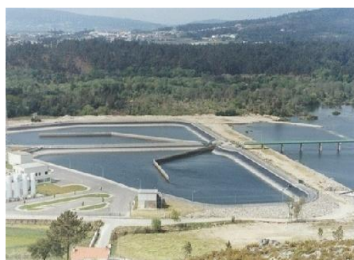
Figura 9. Reservatórios de água bruta (Águas do Cávado, S.A., 2009).
