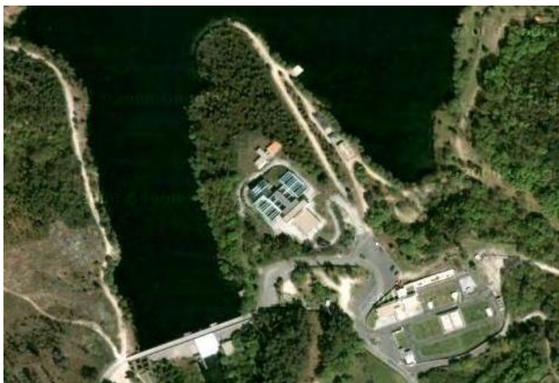
Figura 1. Vista aérea da ETA de Queimadela.
