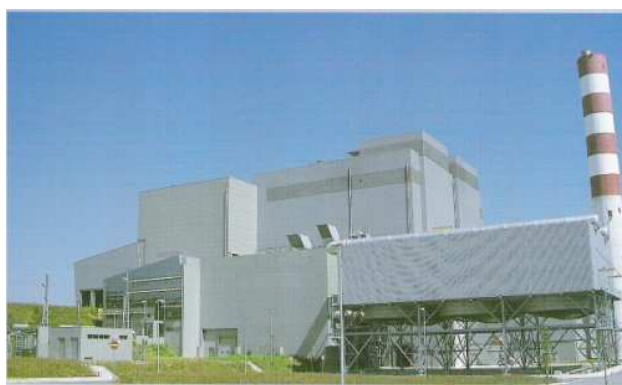
Figura 2 - Central de Valorização Energética da LIPOR II. Fonte: LIPOR, 2002.
