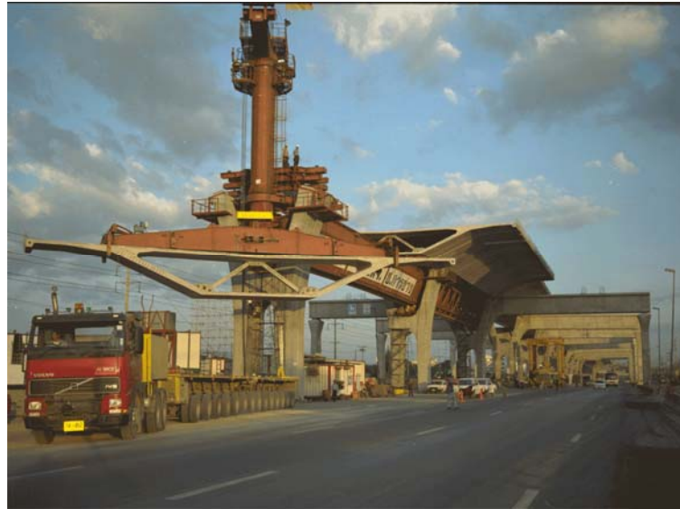
Fig.8 – Equipamento de colocação e elevação autónomo [11]
