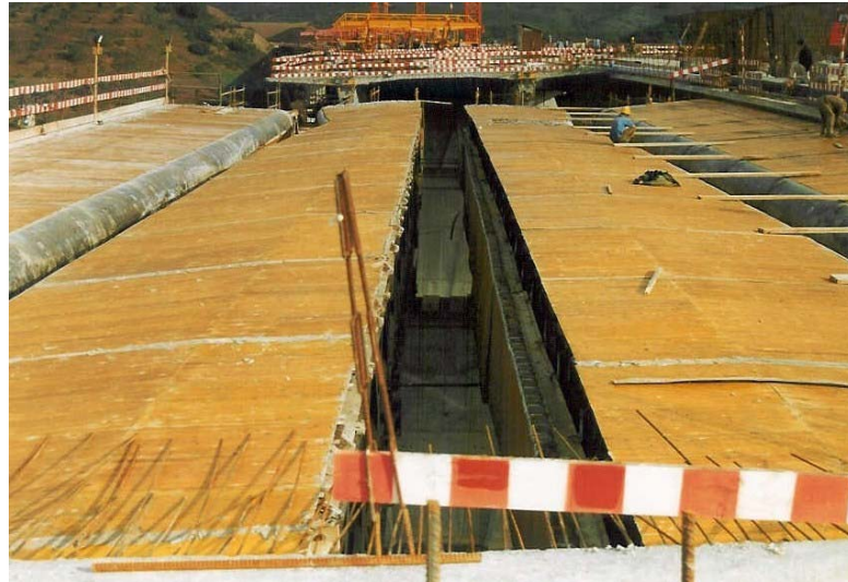
Fig.24 – Afastamento das vigas principais do cimbra móvel para a sua movimentação separada [9]
