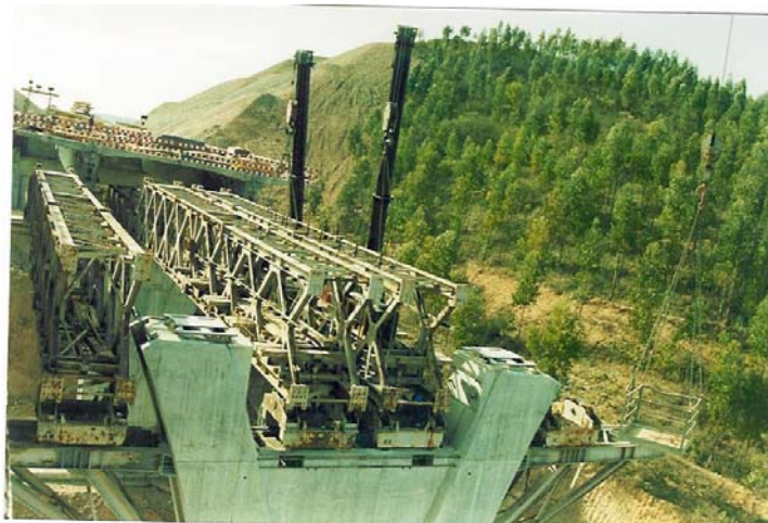
Fig.19 – Montagem por módulos de um cimbra autolançável inferior [9]
