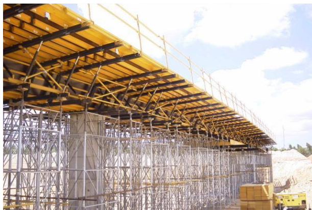
Fig.2 – Escoramento ao solo [11]
