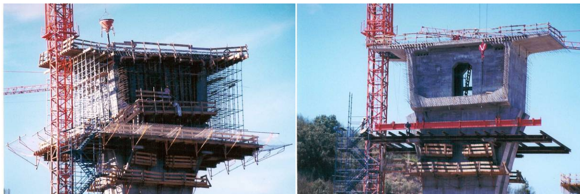
Fig.30 – Execução da aduela zero [9]
