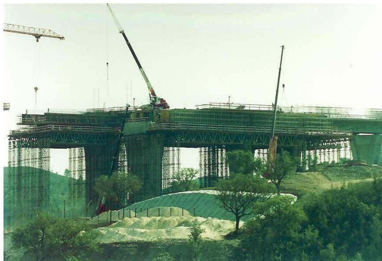
Fig.3 – Cimbra ao solo de asnas e colunas metálicas [9]
