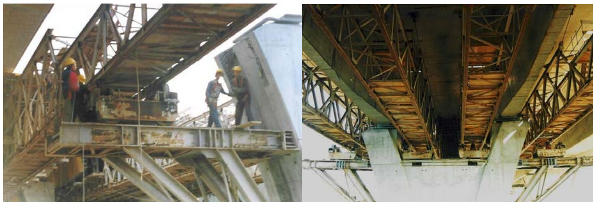
Fig.23 – Consolas e bogies num cimbra autolanzável inferior [9]
