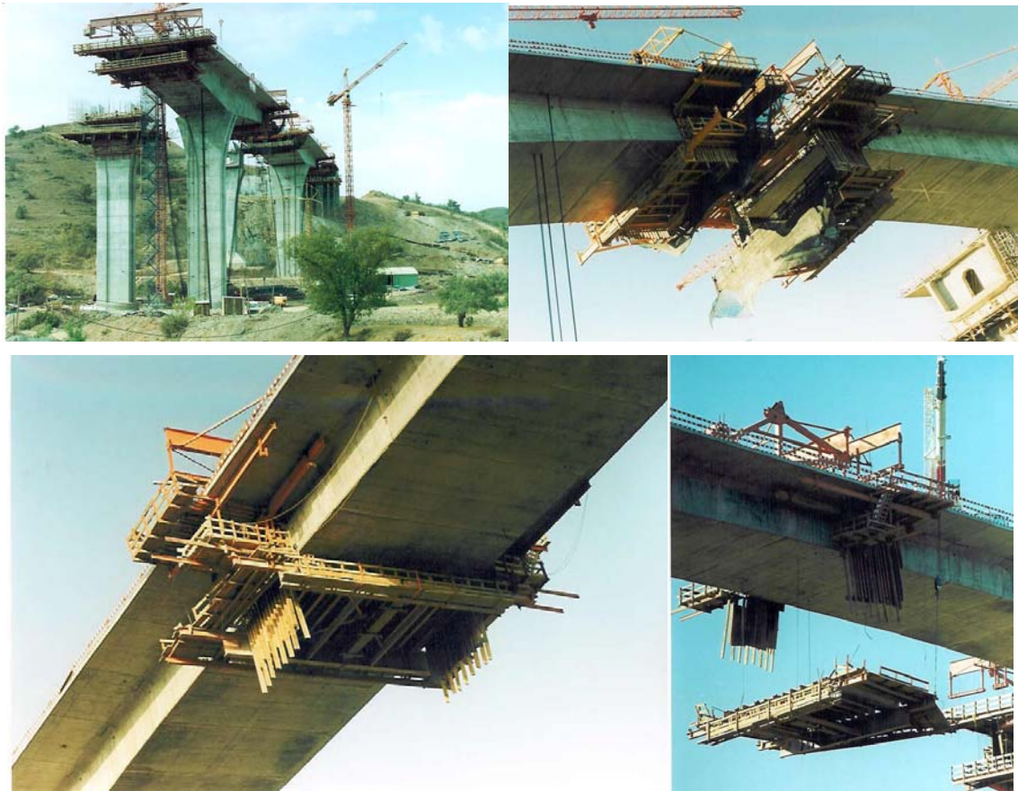
Fig.31 – Método dos avanços sucessivos com carro de avanço: etapas [9]
