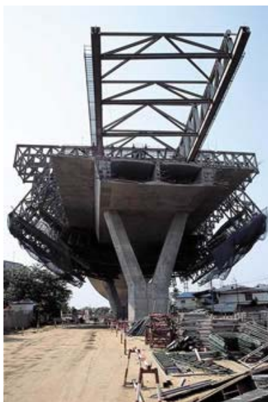
Fig.21 – Abertura da cofragem num cimbra superior [11]
