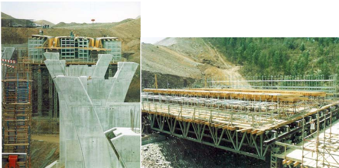
Fig.17 – Montagem de um cimbra ao solo [9]
