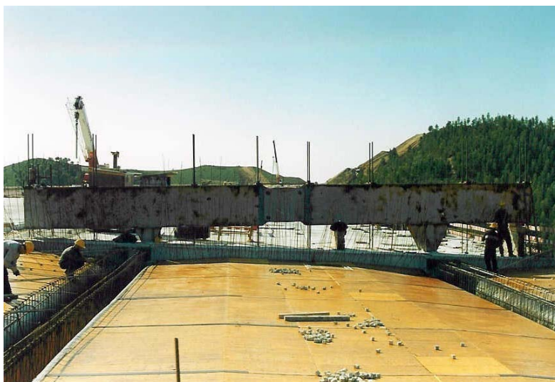
Fig.22 – Montagem da armadura num cimbra inferior [9]
