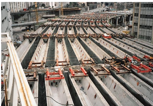
Fig.6 – Vigas pré-fabricadas em caixão [11]
