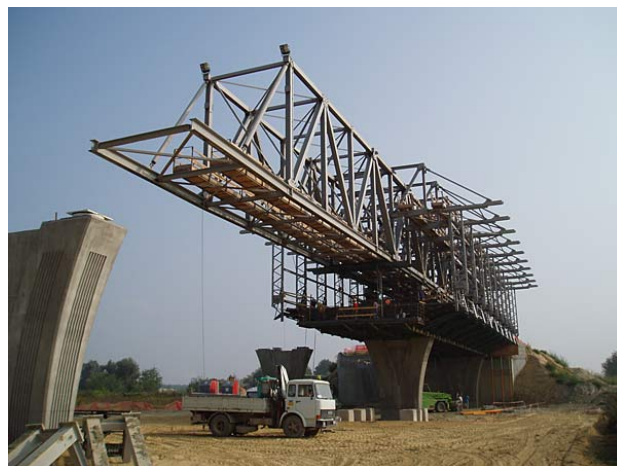
Fig.4 – Cimbra autolançável superior [11]
