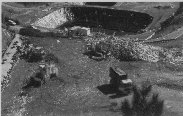
Fig. 10 – Enchimento do Aterro Sanitário da Meia Serra
