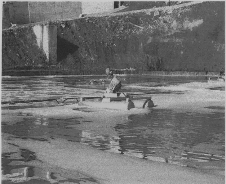
Fig. 11 – Lagoa arejada onde se processa o tratamento biológico.
