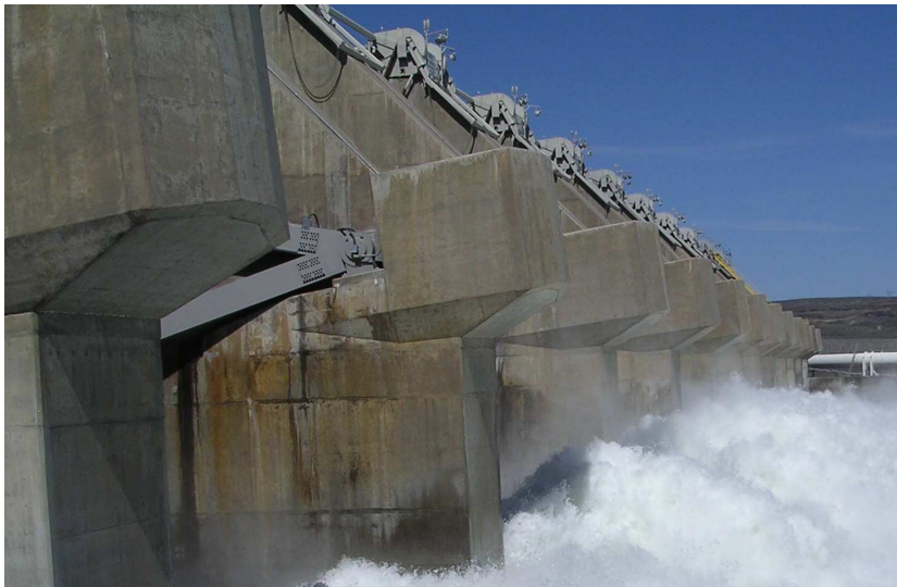
Figura 63 - Bloco de ancoragem da barragem de Wanapum. Adaptado de [41].
