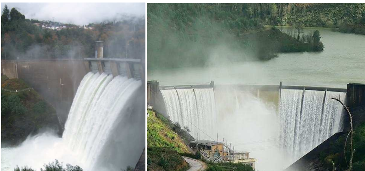
Figura 11- Descarregadores de lâmina ou de jactos livres: à esq. a barragem da Caniçada [18] e à dir. a barragem da Bouçã [19].
