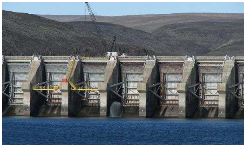
Figura 50- Barragem de Wanapum. Adaptado de [40].
