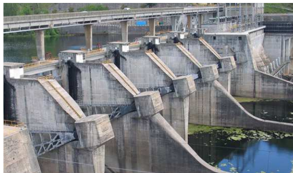
Figura 39 - Blocos de ancoragem da barragem de Fratel. Adaptado de [34].
