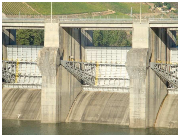
Figura 16 - Comportas segmento da Barragem da Régua.
