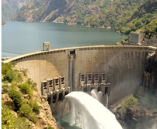
Figura 12 - Descarregadores da barragem de Cahora Bassa. Adaptado de [20].
