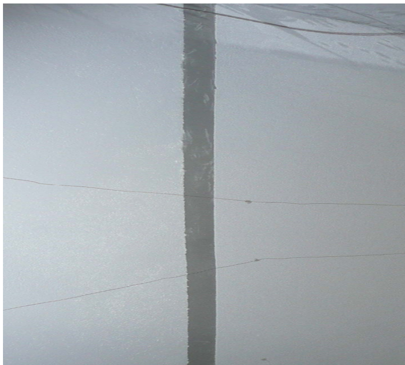
Fig. 14 – Provete ETICS evidenciando os dois revestimentos finais aplicados
