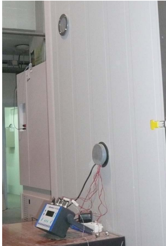
Fig. 12 – Passa-muros vistos do lado exterior
