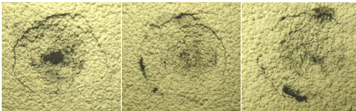
Fig. 70 – Ensaio na parede com RPE
