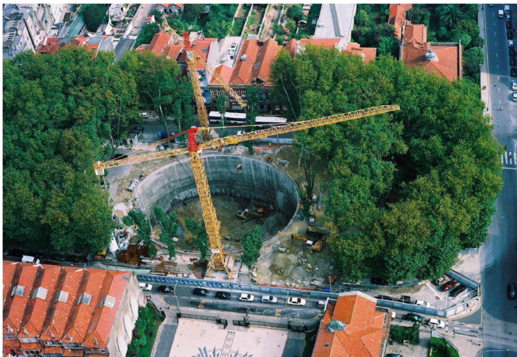
Figura 2.1 – Vista aérea da escavação do poço central da estação Marquês (Topa Gomes, 2008)
