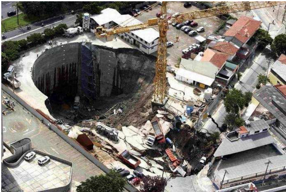
Figura 2.4 – Fotografia aérea após acidente na estação Pinheiros – Metro de S. Paulo (Topa Gomes, 2008)
