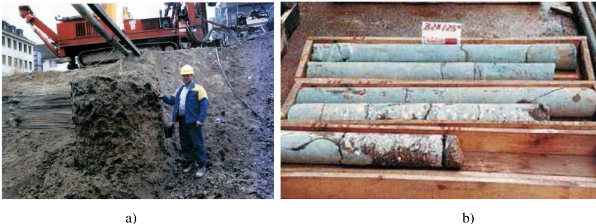
Figura 3.6 – Controlo de qualidade (Pinto, 2008): a) execução de colunas teste; b) recolha de amostras.
