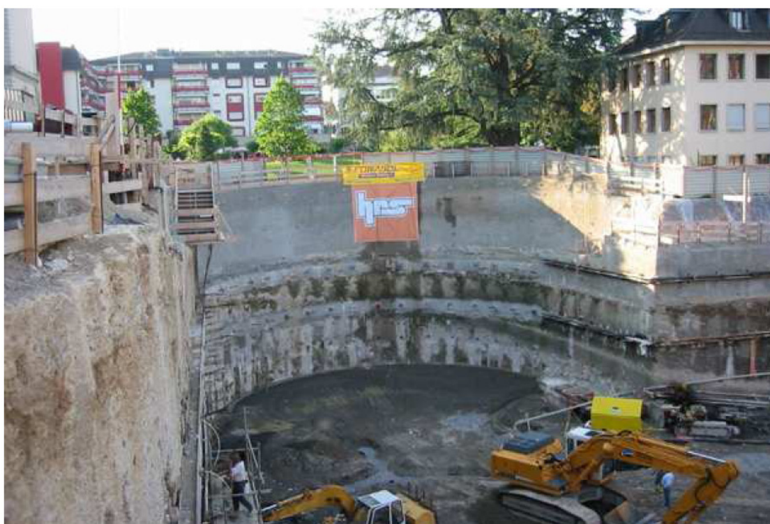
Figura 3.10 – Panorâmica da parede de contenção em jet-grouting (Pinto, 2008)
