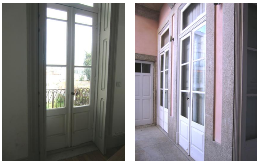
Figura 5.12 – Janela exterior de batente de varanda com portadas interiores.
