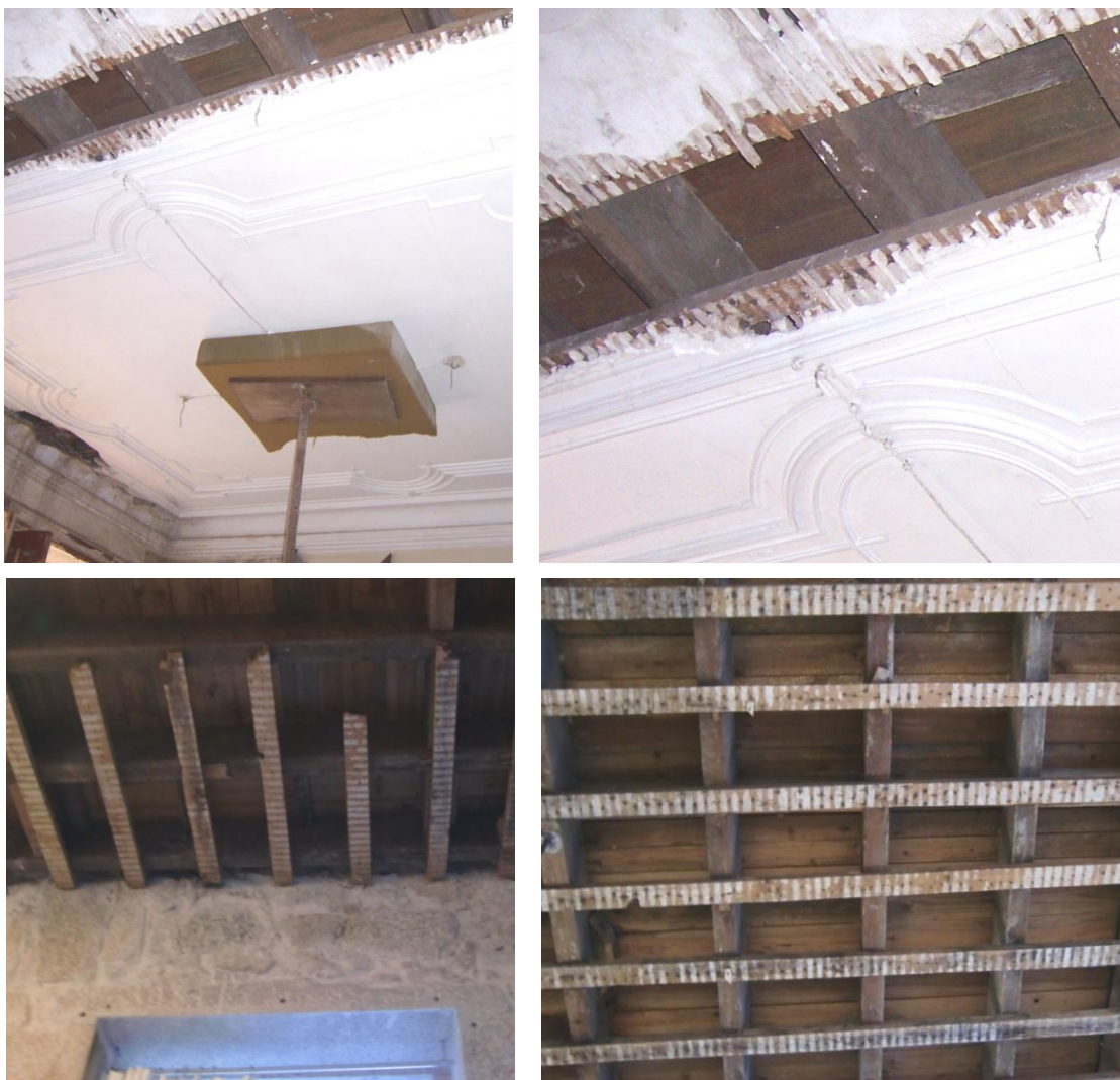
Figura 5.20 – Constituição de pavimento em estrutura de madeira.
