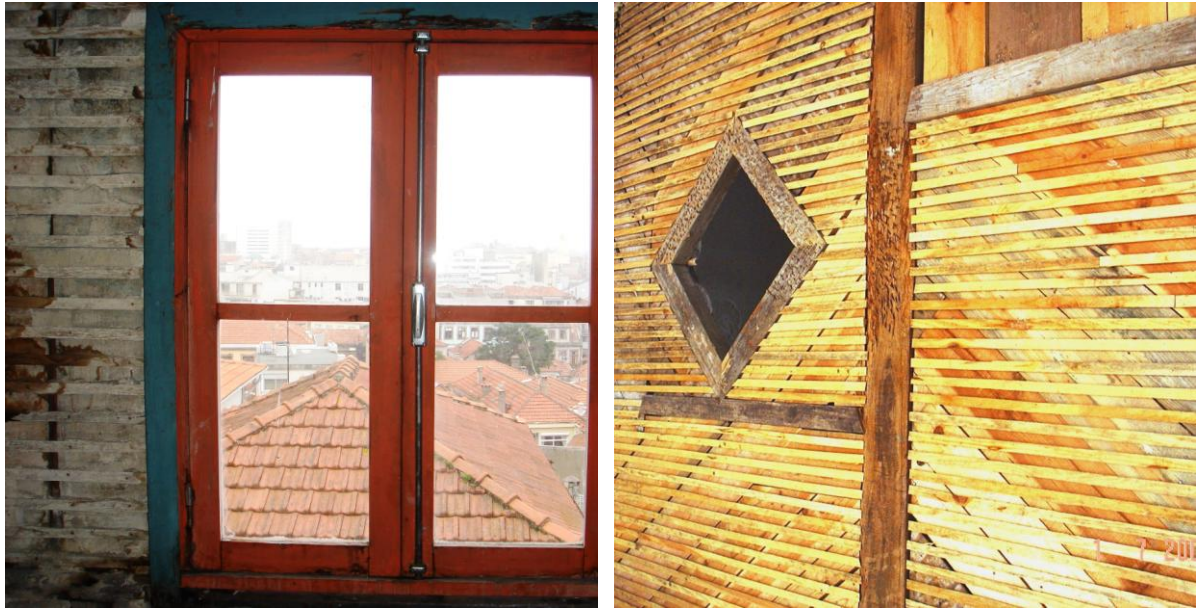
Figura 5.6 – Soluções de paredes exteriores em tabique. [26]
