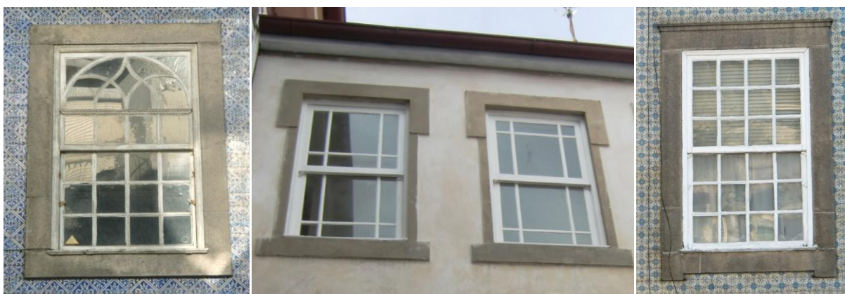
Figura 5.13 – Janela exterior de guilhotina.
