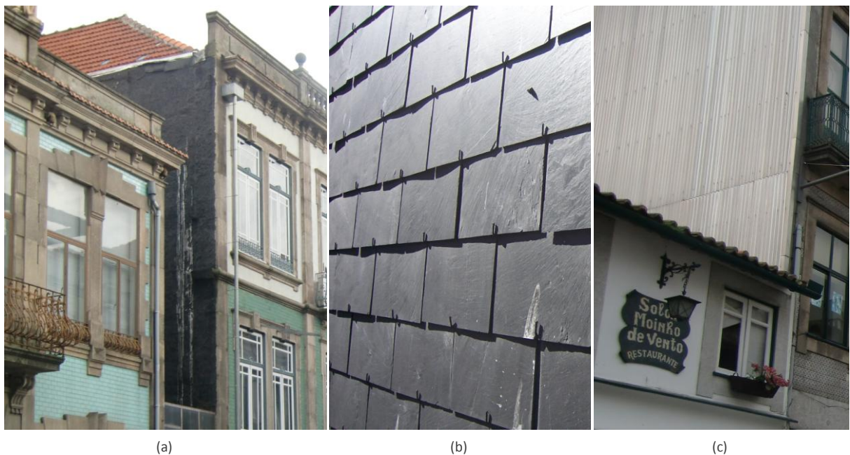
Figura 5.7 – Paredes de empena revestidas por asfalto (a), soletos de ardósia (b) e chapa zincada (c).
