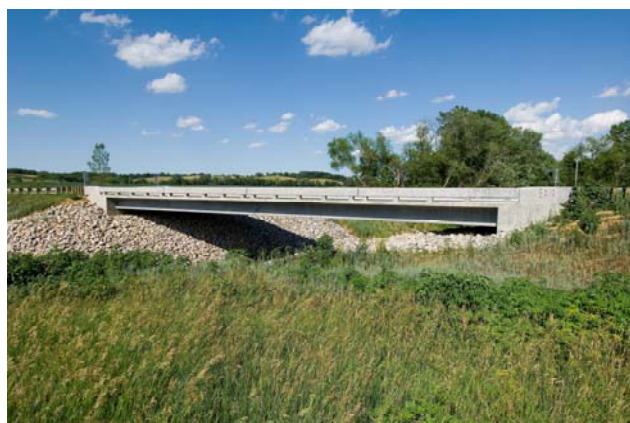
Figura 2.7. – Ponte Mars Hill em Wappelo County, Iowa [29]
