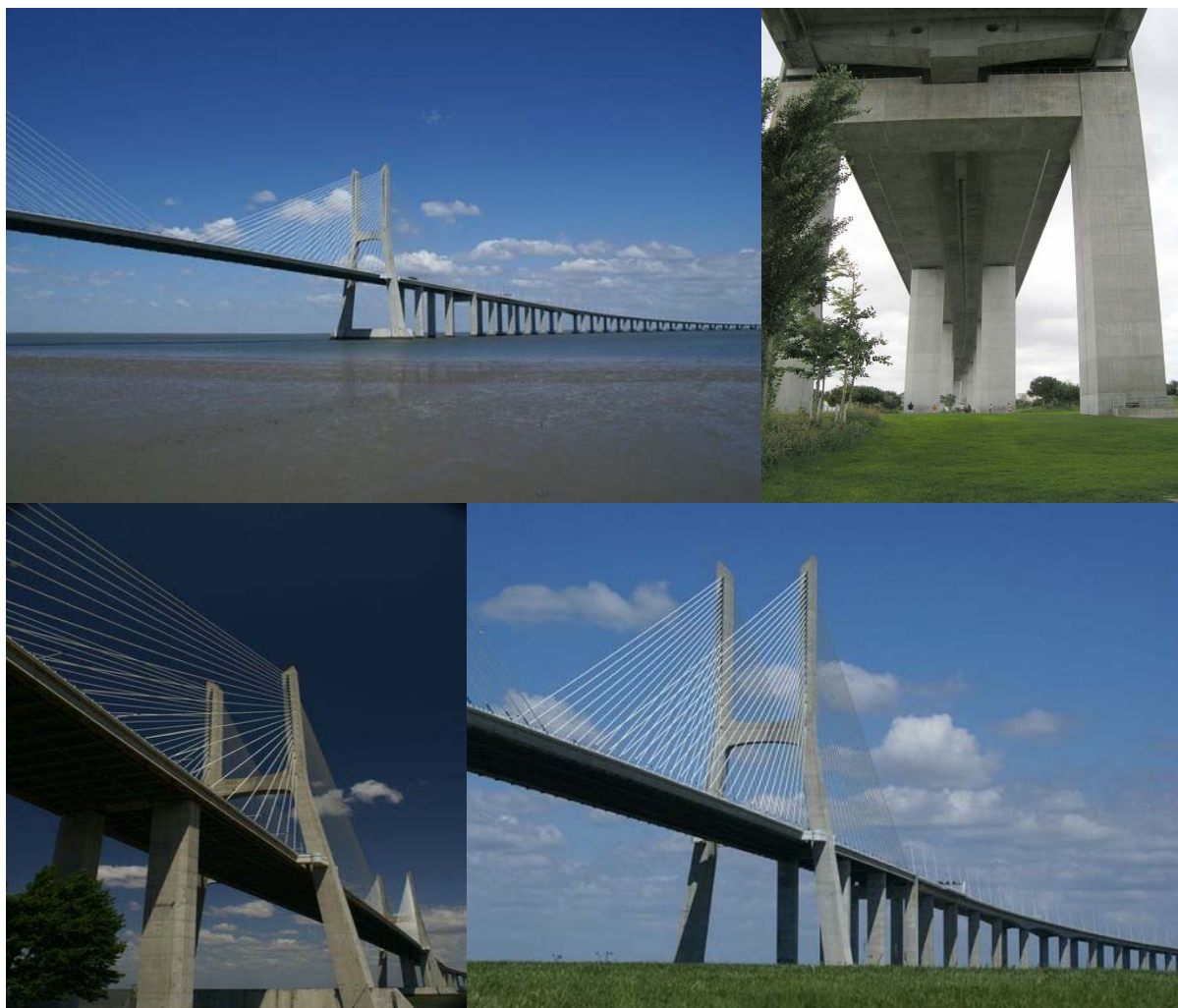
Fig.2.6. – Ponte Vasco da Gama (Portugal)
