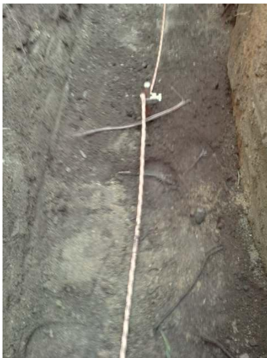
Figura B.4 - Pormenor da ligação do cabo rectilíneo horizontal ao eléctrodo vertical.
