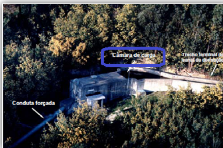
Figura 2.7 - Câmara de Carga de uma Central Mini-Hídrica [17].
