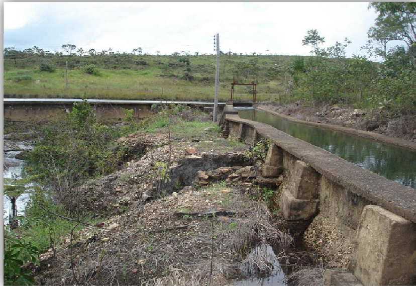
Figura 2.6 - Canal de adução de uma Central Mini-Hídrica [4].
