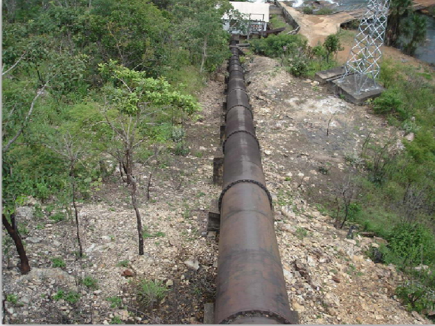
Figura 2.8 - Conduita forçada de uma Central Mini-Hídrica [4].
