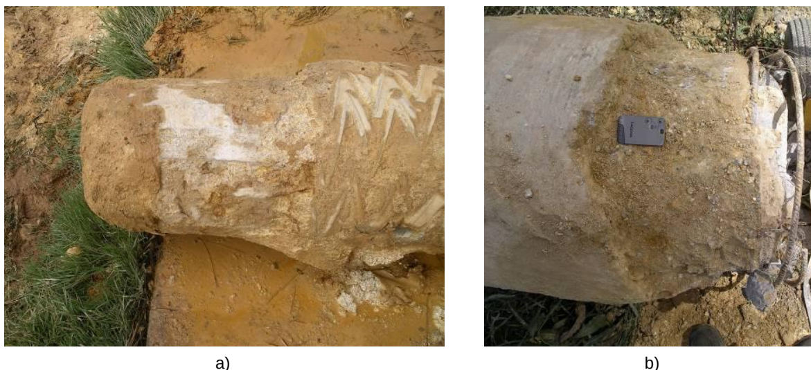
Fig. 4.31 – Pormenor da ponta das estacas moldadas após a extracção (Costa Esteves, 2005)
