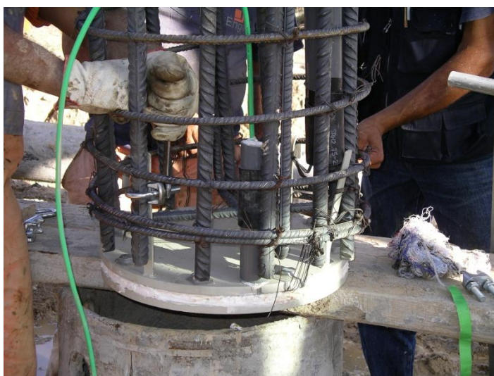
Fig. 4.17 – Célula de carga (pormenor da montagem)
