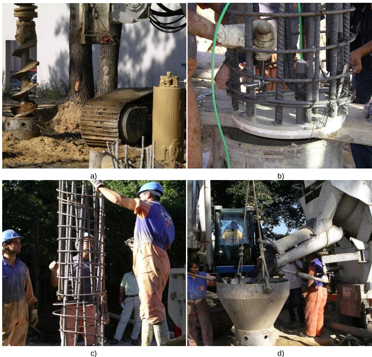
Fig. 4.11 – Execução das estacas moldadas: a) Trado e limpadeira; b) Colocação da instrumentação; c) Colocação da armadura; d) Betonagem
