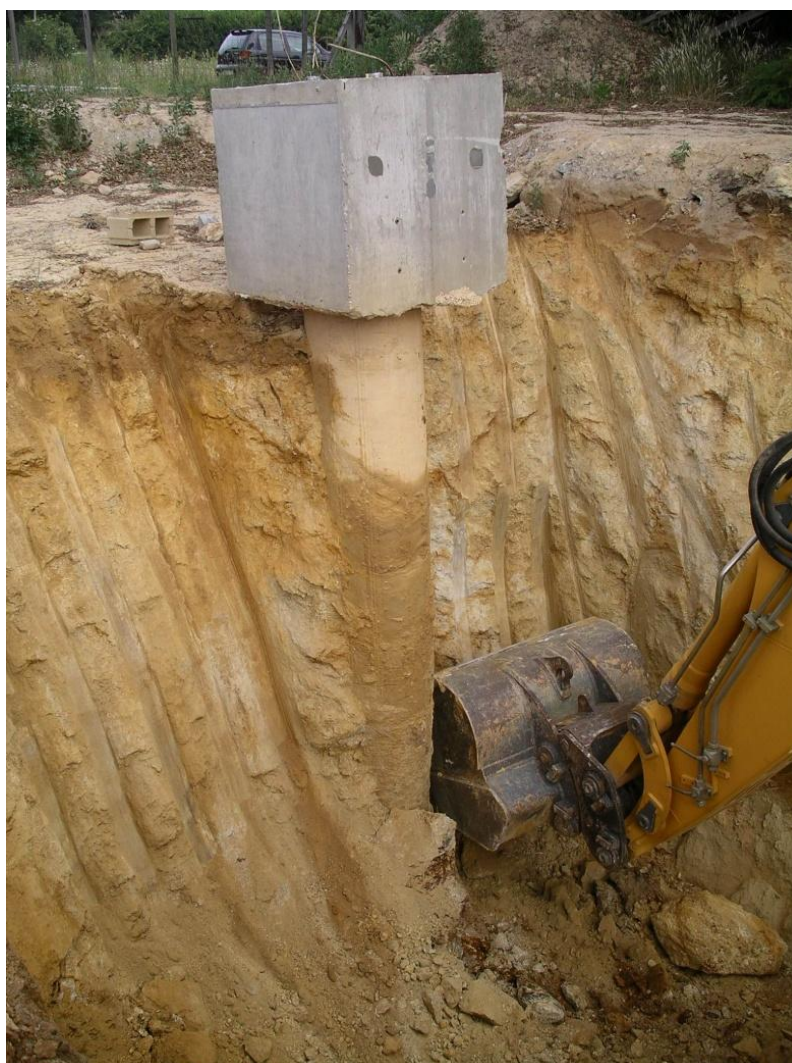
Fig. 4.30 – Escavação faseada – exemplo para a estaca moldada
