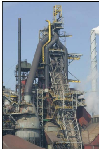
Ilustração 10 - Aspecto real de um alto-forno [9]
