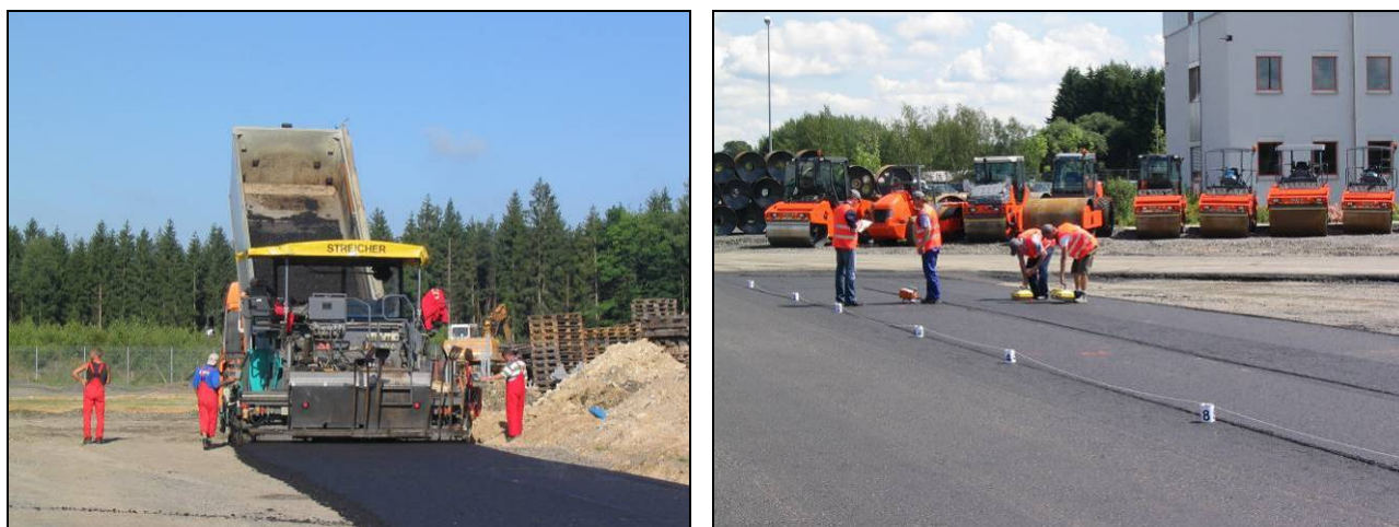
Figura 3.9 – Fotos das operações de pavimentação e monitorização dos resultados
