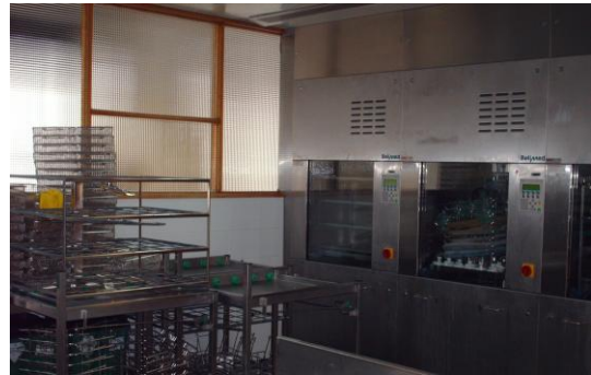
Figura 1 – Área de Descontaminação
