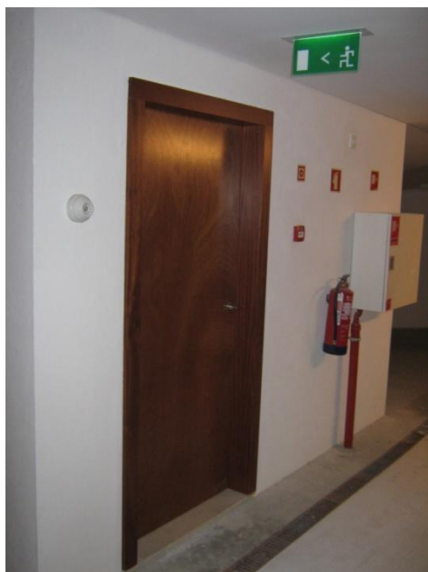
Fig.2.37 – Sinalização de saída nos estacionamentos
