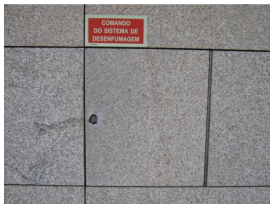
Fig.2.38 – Indicação do local de comando do sistema de desenfumagem
