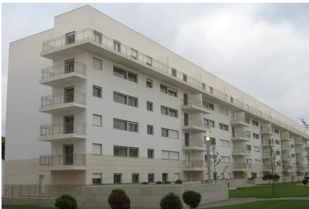
Fig.4.11 – Vista do alçado poente e do alçado lateral norte
