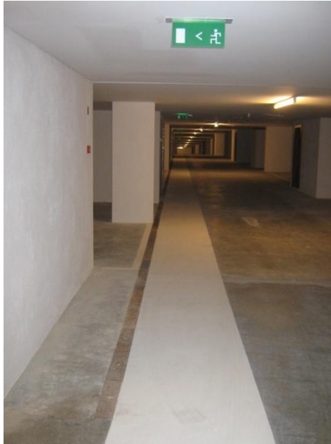
Fig.2.34 – Os caminhos de evacuação e as saídas dos pisos de estacionamento estão bem sinalizados e iluminados
