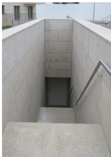
Fig.4.14 – Escadas de ligação directa entre os estacionamento e o exterior
