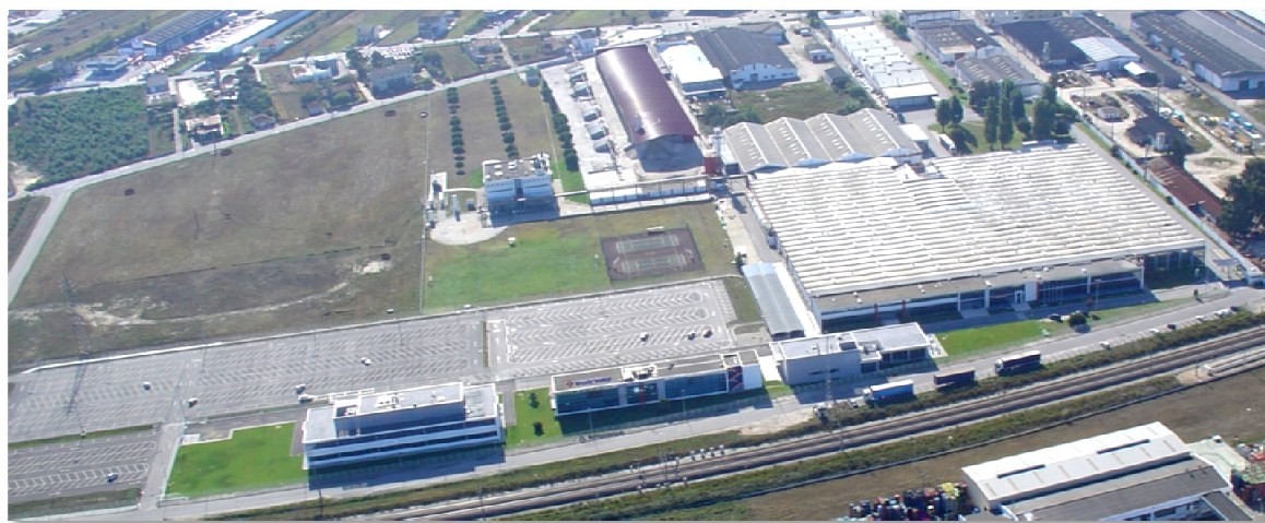
Figura 3 – Actuais instalações da Bosch Termotecnologia SA. em Cacia, Aveiro Fonte: Intranet Bosch
