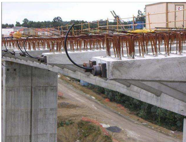
Fig.2.8. – Zona de ancoragem com aplicação do sistema de pré-esforço na Ponte de Vegarrozadas, Espanha [3]
