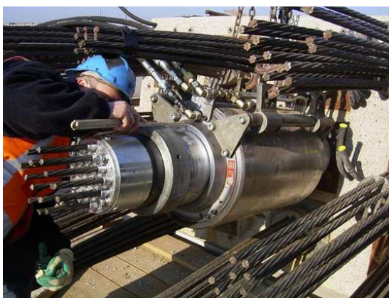
Fig.2.1. – Esticamento dos cabos para aplicação do pré-esforço [4]
