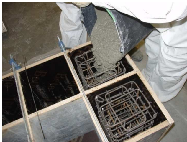
Fig.3.2. – Betonagem de um dos modelos
