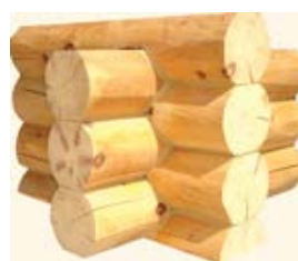
Fig.2.35 – União em “Sadle notch”
