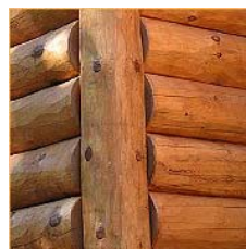
Fig.2.43 – União em “Corner post”
