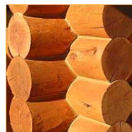
Fig.2.24 – Exemplo de “Swedish Scope”
