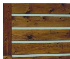
Fig.2.26 – Exemplo de “Chink & Groove”
