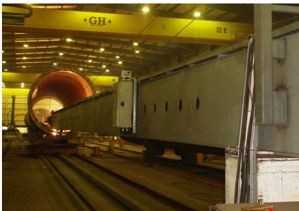
Figura 27 – Troço a ser soldado pelo seu interior
