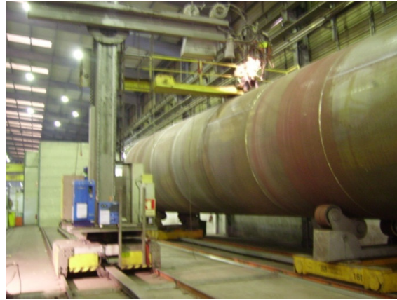
Figura 22 – Processo de soldadura exterior de troço de uma torre eólica
