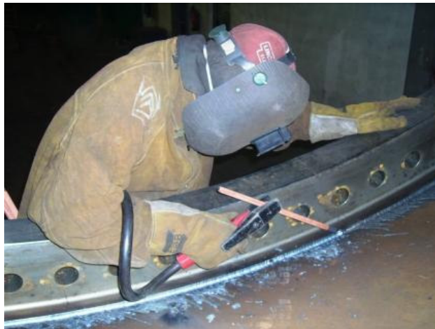
Figura 24 – Junta flange/viola arqueada
