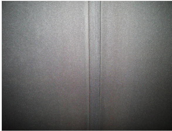
Figura 35 – Troço depois do processo de decapagem
