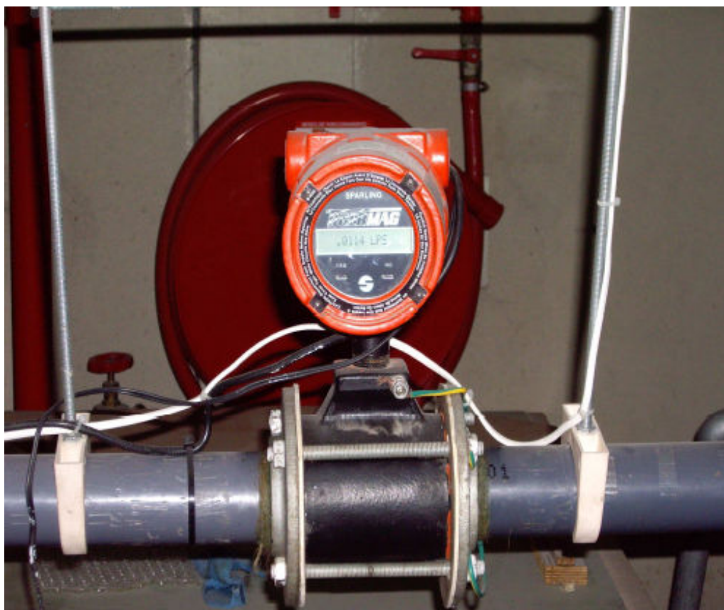
Figura 3.13. - Equipamento do tipo electromagnético para medição de caudais
