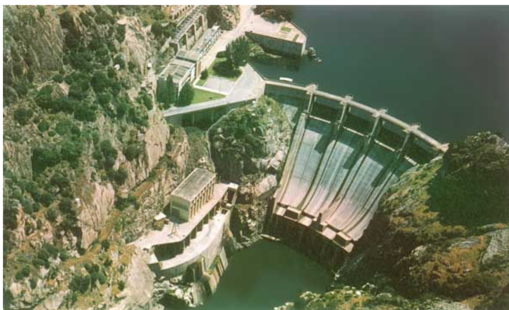
Figura 2.10. - Barragem de Picote, sistema de dissipação por salto de esqui
