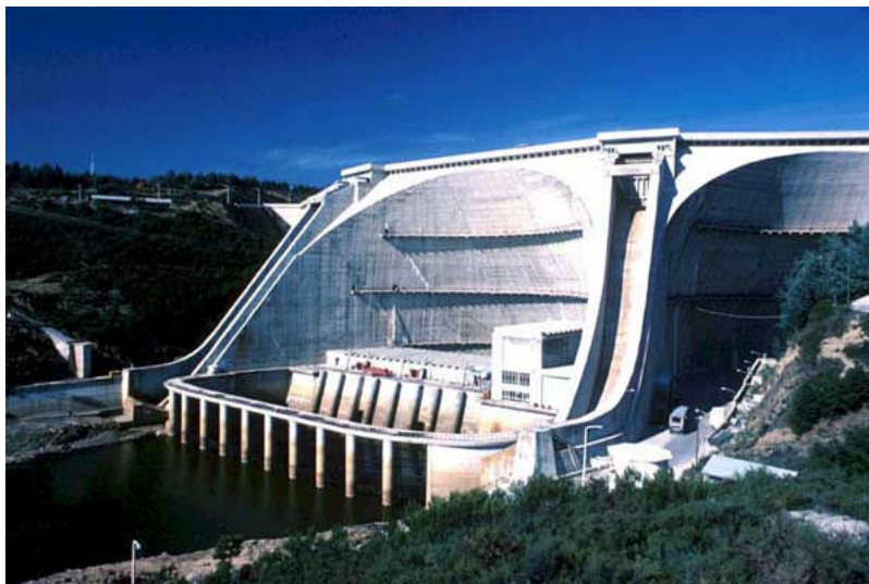
Figura 2.11. - Barragem da Aguieira, sistema de dissipação por jactos cruzados
