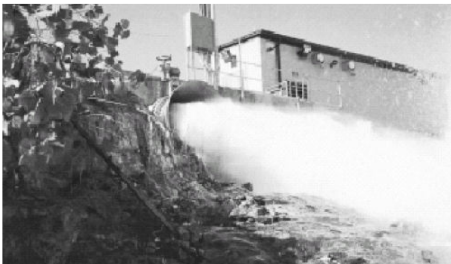
Figura 2.9. - Saída do escoamento de uma válvula multi-jacto
