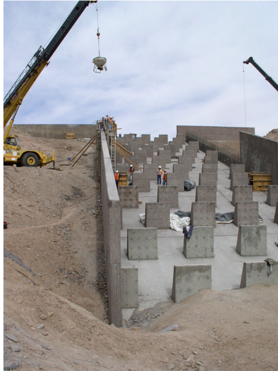
Figura 2.4. - Construção de rampa de blocos em Sierra County, New Mexico, E.U.A.
