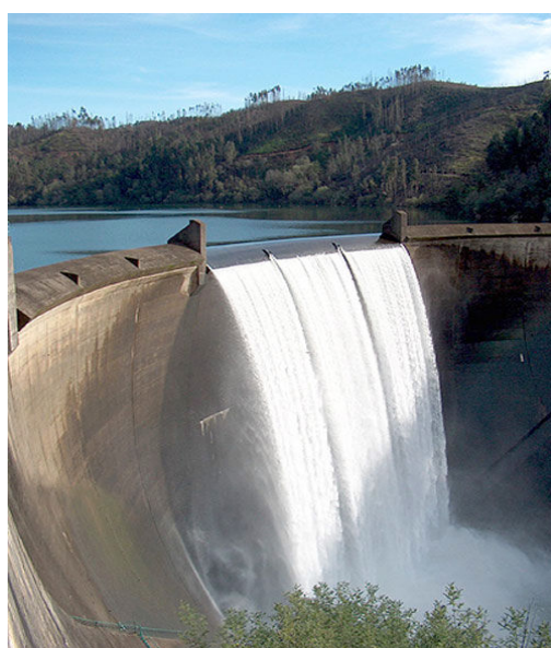
Figura 2.6. - Exemplo de dissipação por queda livre, Barragem de Bouçã
