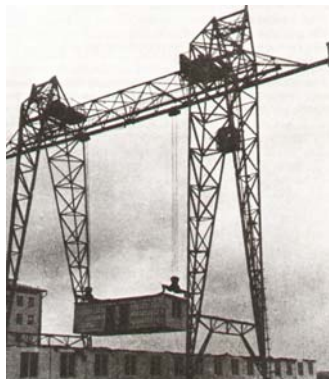
Figura 54 – Colocação de módulos tridimensionais de habitação – URSS.
