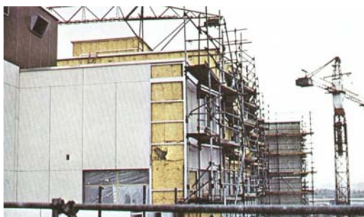
Figura 66 – Aplicação de painéis leves de alumínio para revestimento exterior de edifício de habitação colectiva.
