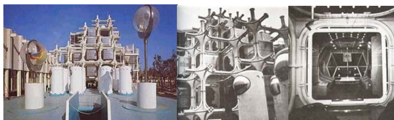
Figura 61 – Takara Beautillion, vistas do exteriores do conjunto, e do interior de uma célula. – Osaka, Japão, Arquitecto Kisho Kurokawa, 1970.
