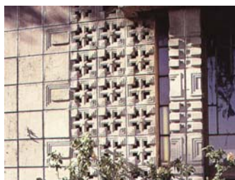
Figura 38 – Aplicação de blocos pré-fabricados na construção da casa Storer, Arquitecto F.L. Wright, 1923.
