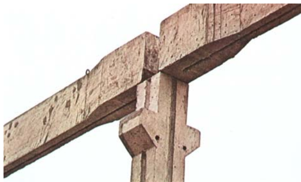
Figura 70 – Montagem de pórtico pré-fabricado de betão.
