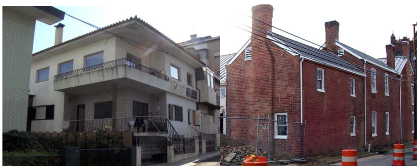
Figura 9 – Casa executada com pórticos estruturais de betão armado com preenchimento em alvenaria de blocos, na Areosa, e conjunto de casas executadas em alvenaria de tijolo maciço à vista de um bairro industrial Norte Americano.
