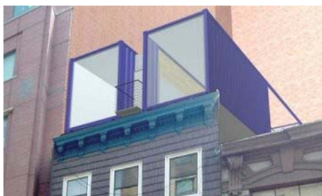
Figura 69 – Células estruturais metálicas, colocadas sobre edifício.
