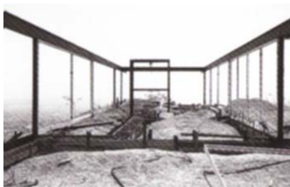
Figura 71 – Montagem da estrutura da “Case Study House 22” ou “Stahl House” – Los Angeles, USA, Arquitecto Pierre Koenig, 1959.
