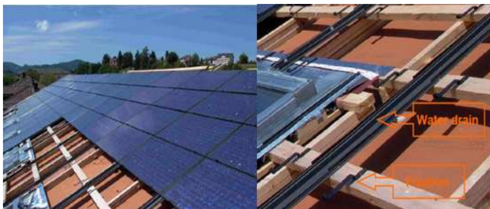
Figura 2.27 - Sistema de montagem tipo para integração de sistemas FV em telhados inclinados [35].
