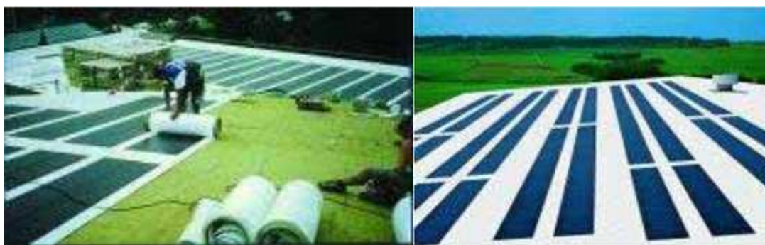
Figura 2.30 - Aplicação de tela solar em telhados planos [20].
