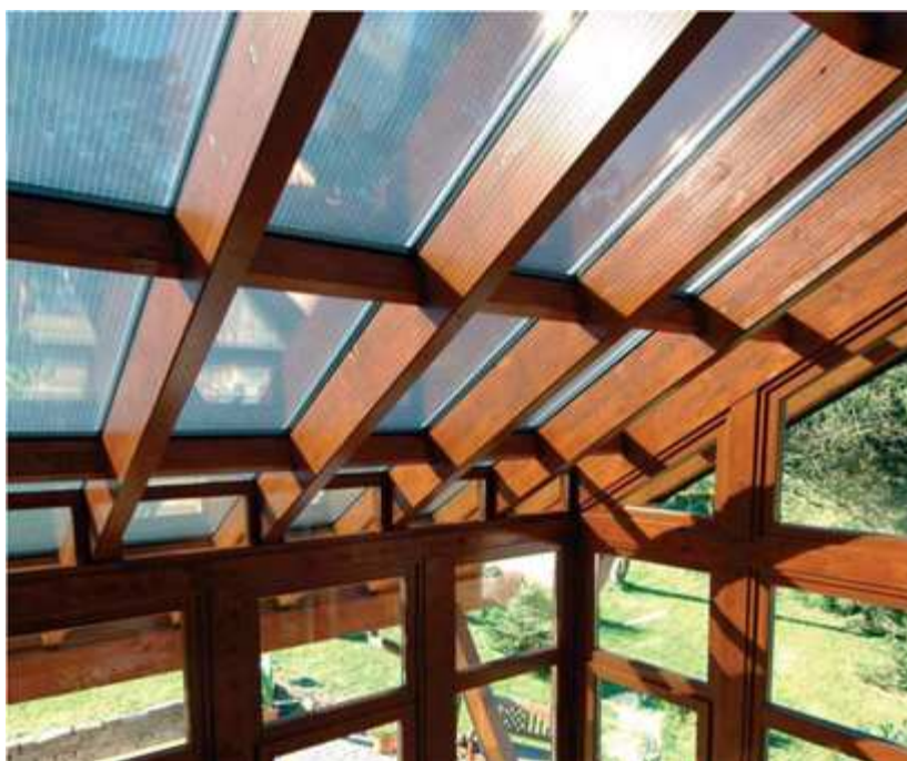
Figura B.2 - Módulos semi-transparentes fotovoltaicos de filmes finos [29].
