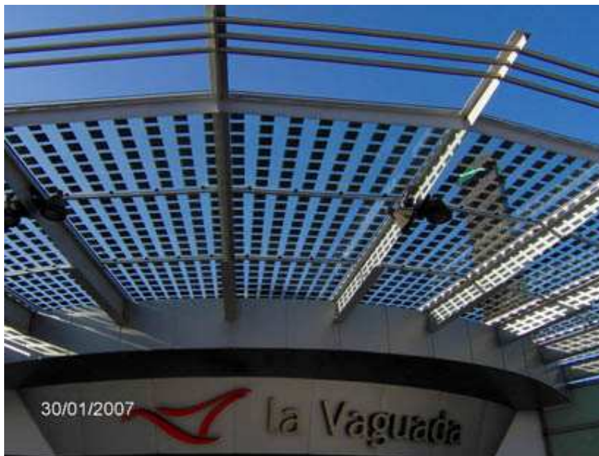
Figura B.3 - Módulos semi-transparentes fotovoltaicos de silicio policristalino [29].
