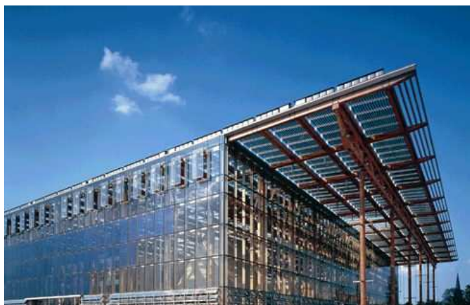
Figura 2.2 - Edifício Mont-Cenis Academy Herne Sodingen , Alemanha [16].
