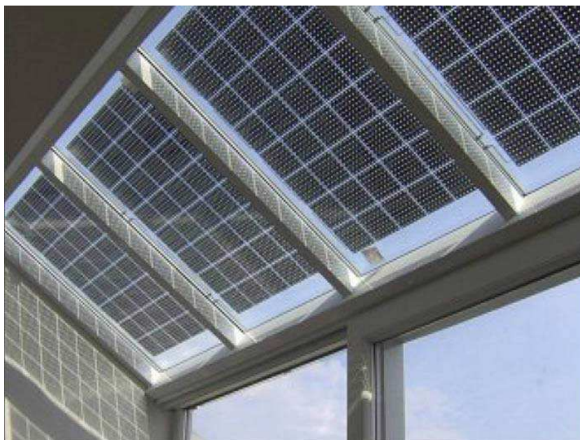
Figura B.1 - Módulos semi-transparentes fotovoltaicos de silício monocristalino [29].
